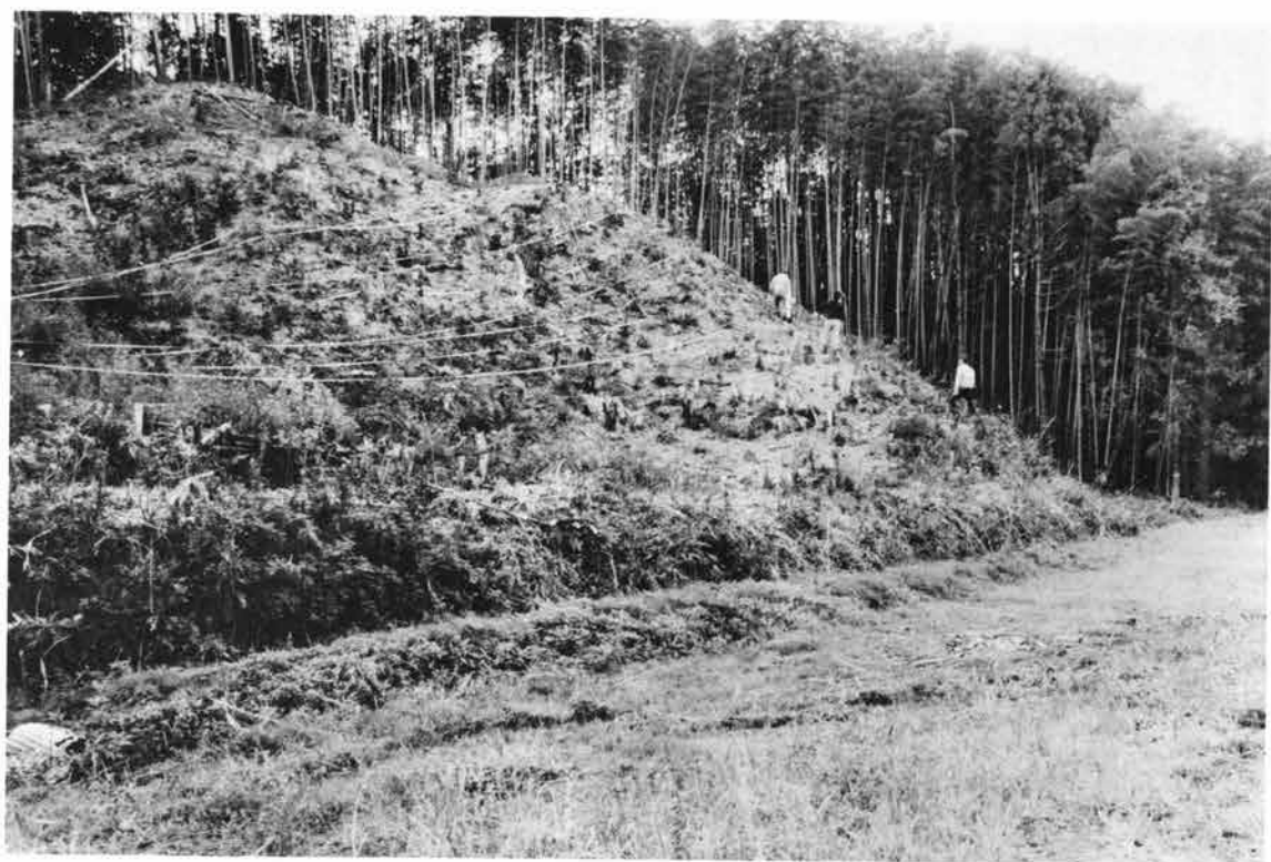
(2)磁気探査風景 (北東から)
