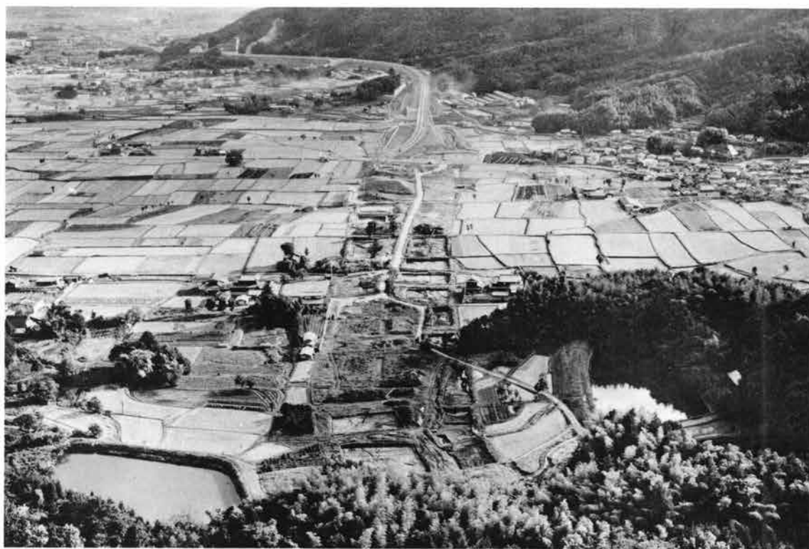
(1)調査地遠景（北から）
