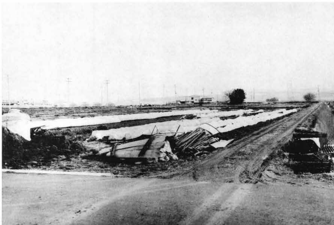
(1) 昭和63年度調査前全景（北西から）
