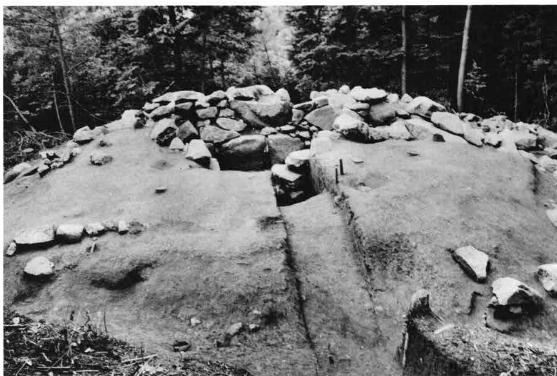
(2) 墳丘全景 (南東から)
