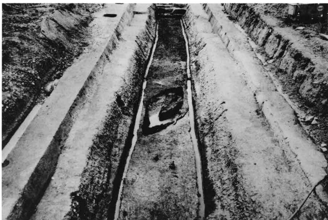
(2) 最下層掘削状況 (東から)
