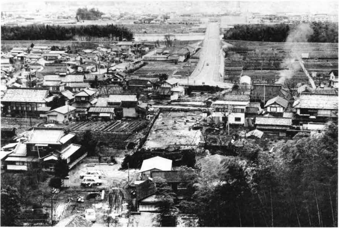
(1) 調査地遠景(北から)
