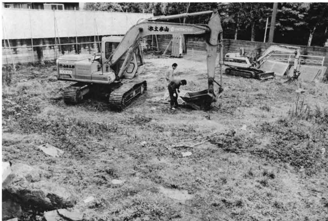
(1) 調査前風景(南東から)
