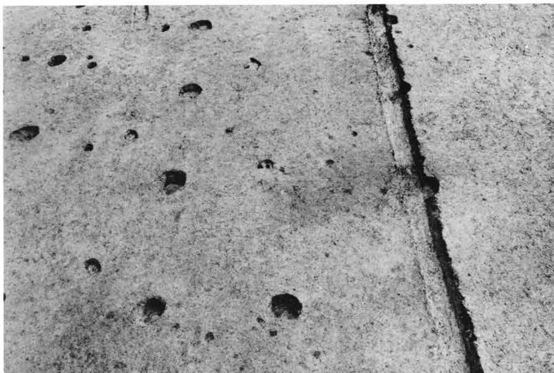
(1) 掘立柱建物跡 S B9021(北西から)
