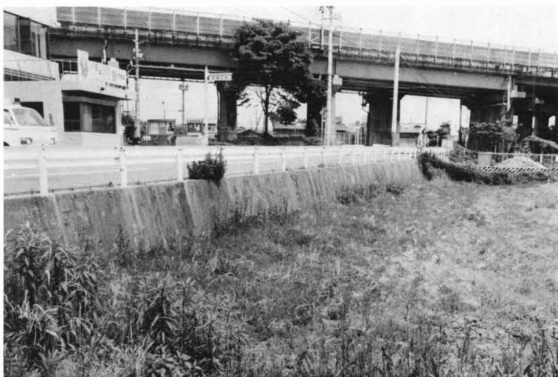
(1) 調査前風景(南から)
