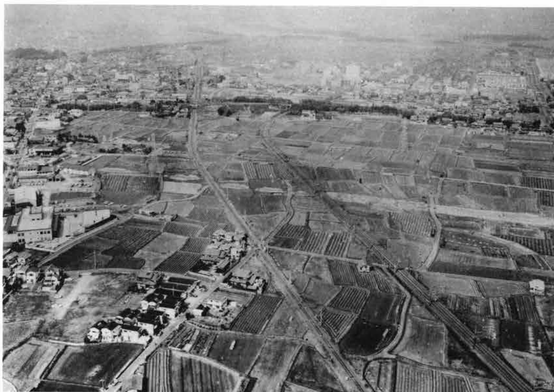
(2) 調査地全景(南から)
