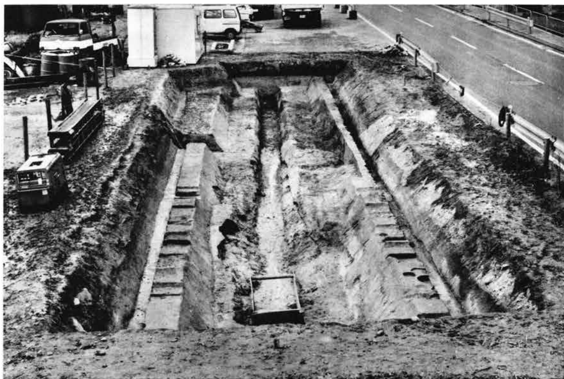
(2) トレンチ断ち割り（東から）
