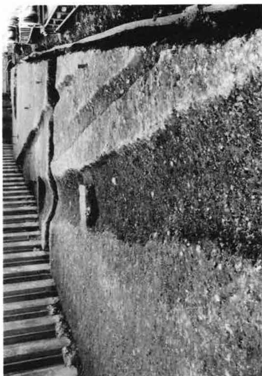
(3) 6 B.L. 9 tr 東二坊大路東側溝 S D24123 (北方から)
