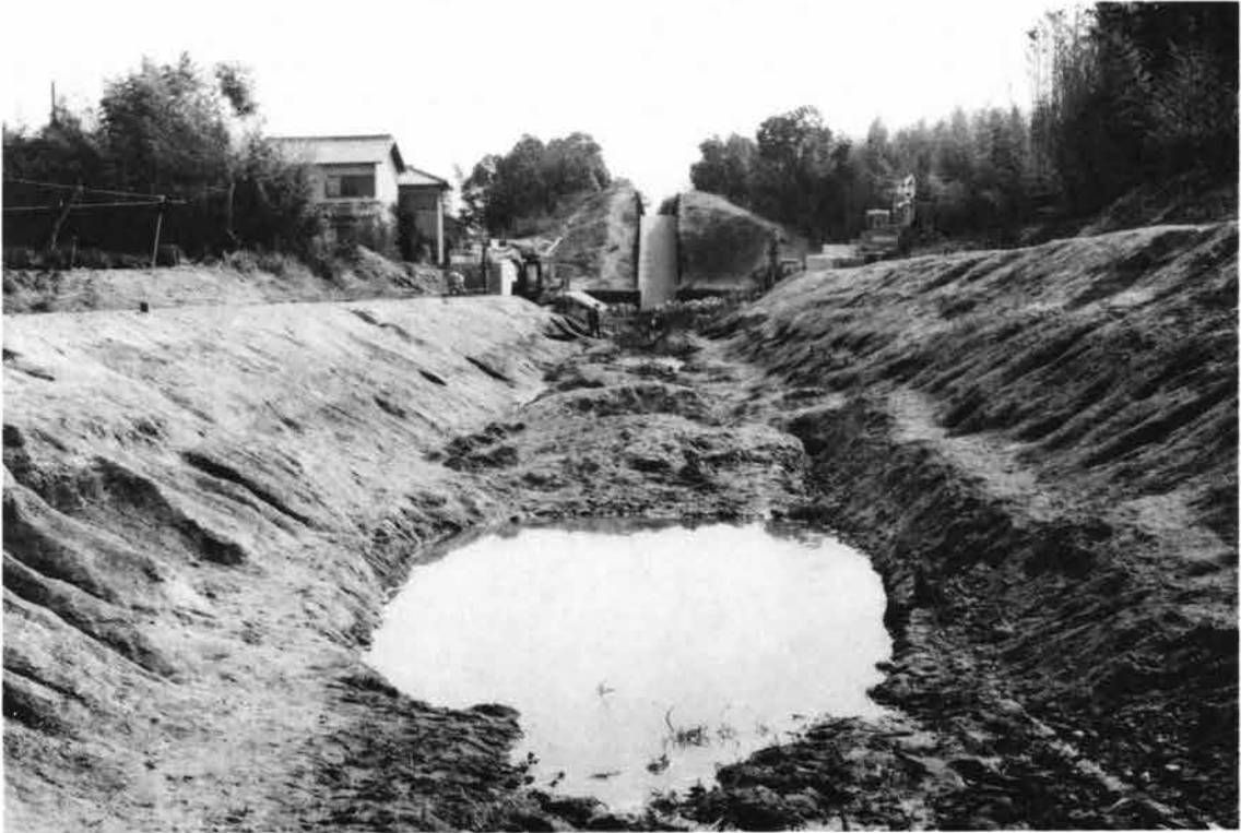
(1) 調査地全景（中央奥が防賀川天井部盛り土：北から）
