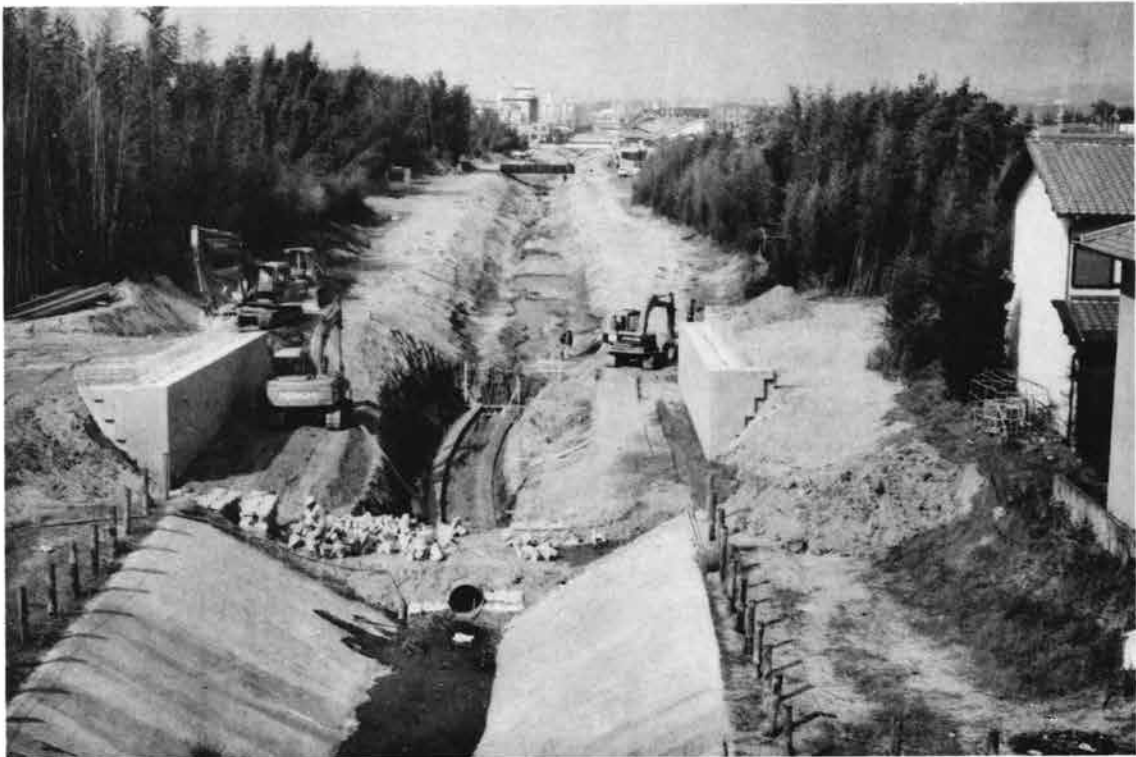
(2) 調査地全景（防賀川天井部盛り土から）
