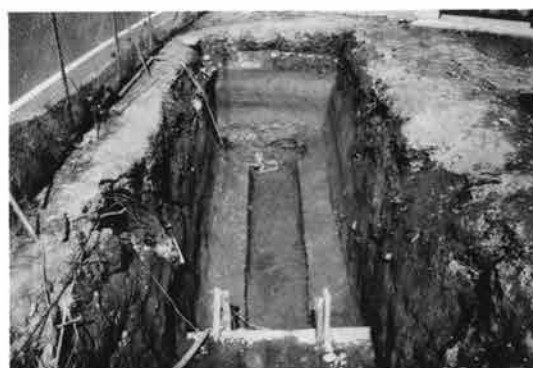
(5) 第4トレンチ北部全景 (南から)
