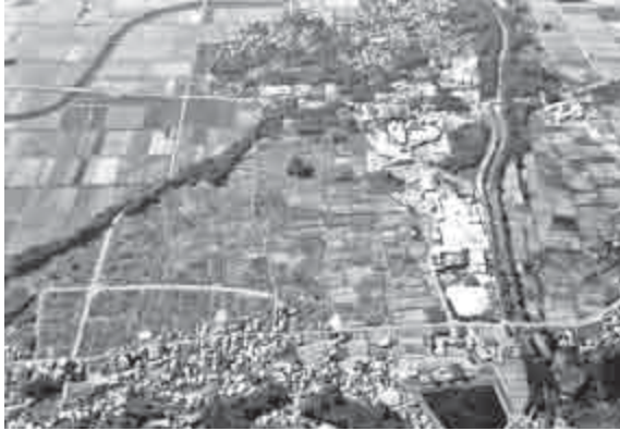
国分寺遠景（東上空から）
