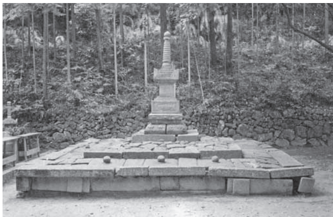
重要文化財三宝院宝篋印塔（修理前）
