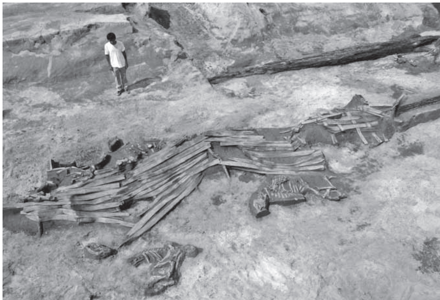
濠の護岸遺構
