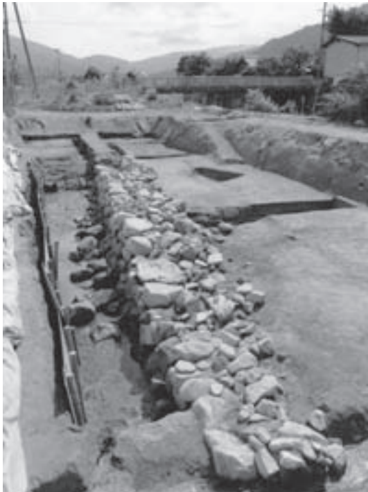
三の丸隅舛形虎口の石垣（北東から）
