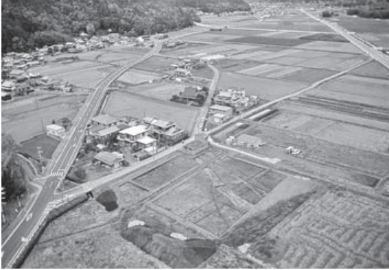
写真1 調査地遠景(南東から)
