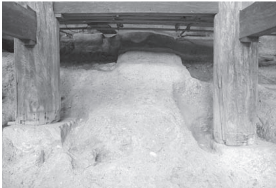
写真1 調査地近景 (南から)
