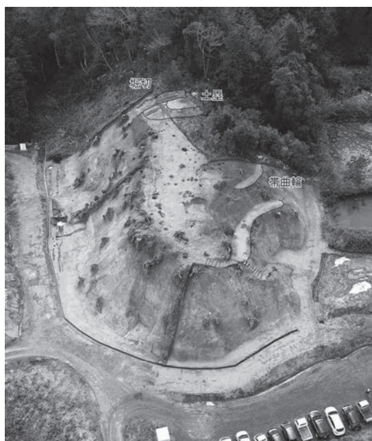
調査地全景(上空から・上が南)
