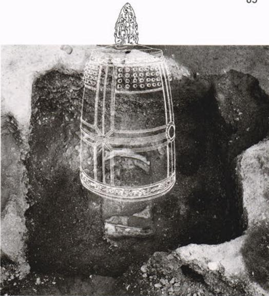
◀ 釣鐘を作るための穴 京都市広隆寺 10世紀 穴底に鑄型を据えるための土台(定盤)を置き、鑄型に溶けた青銅を流し込む。ここでは土台の一部と鑄型を締めつけ固定する締木を据えた穴が見つっている。
