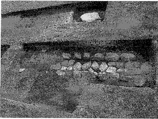
写真2 建物501の北西雨落溝（北から）
