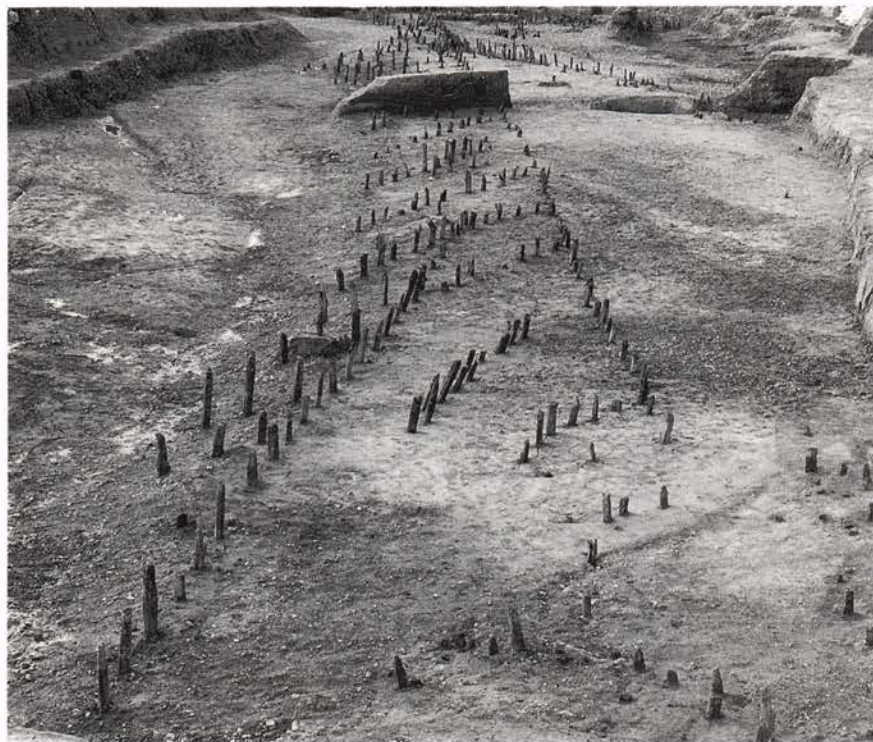
▲ 大規模な土木工事
