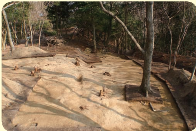
虎口部分の調査
