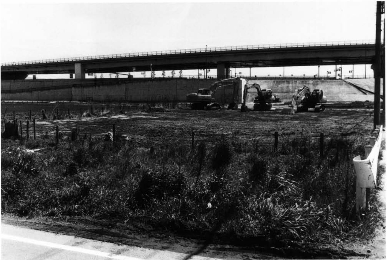
(1)第2トレンチ調査前全景(北西から)
