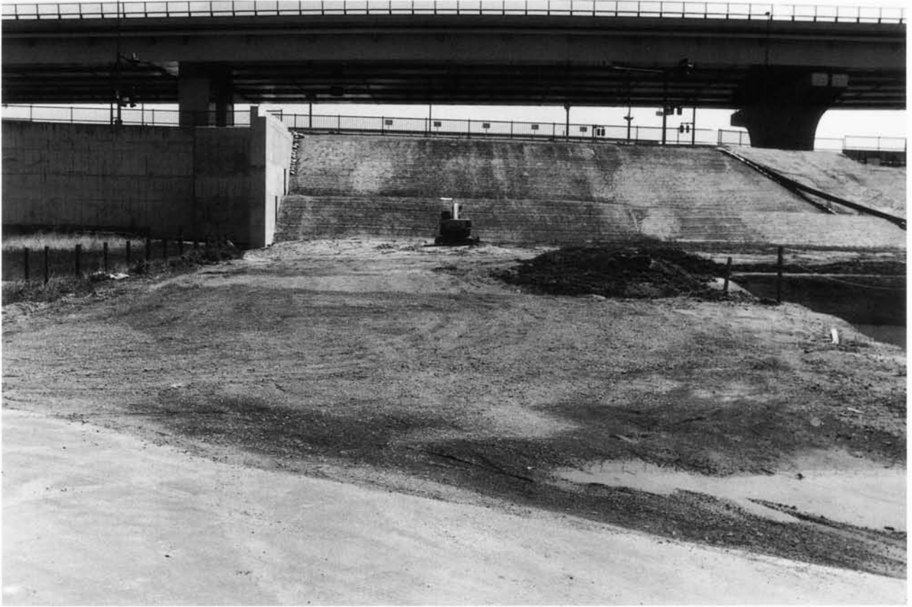
(1)第3トレンチ調査前全景(北西から)
