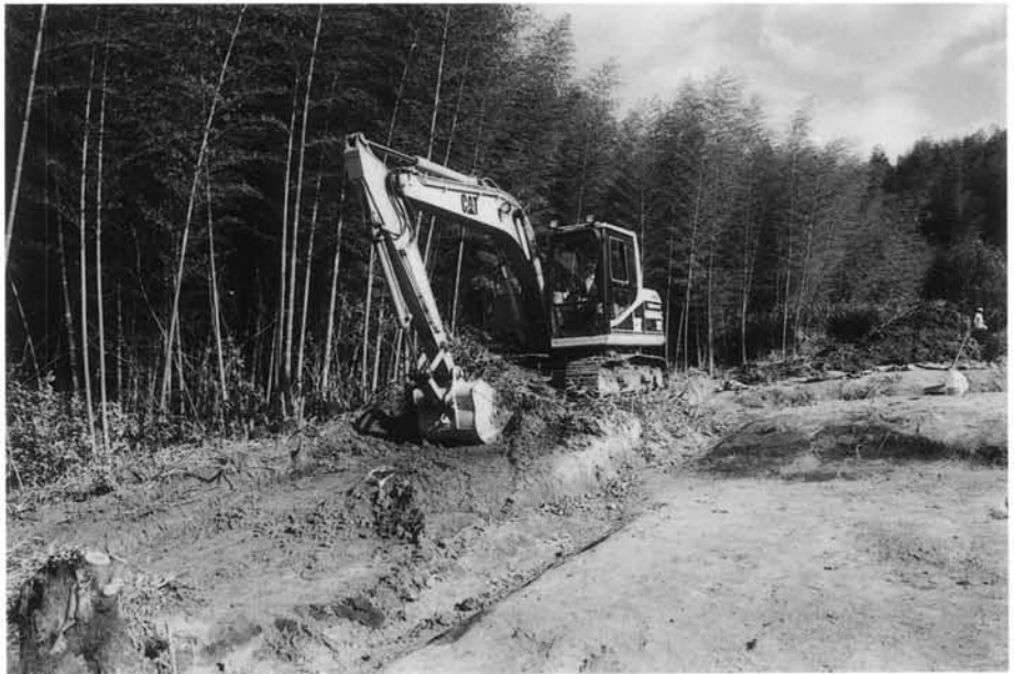
(2)重機掘削作業風景(南西から)
