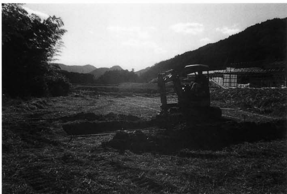
(2) 1 - b トレンチ重機掘削 作業風景(北西から)
