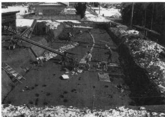
第1図 掘削作業風景(南東から)
