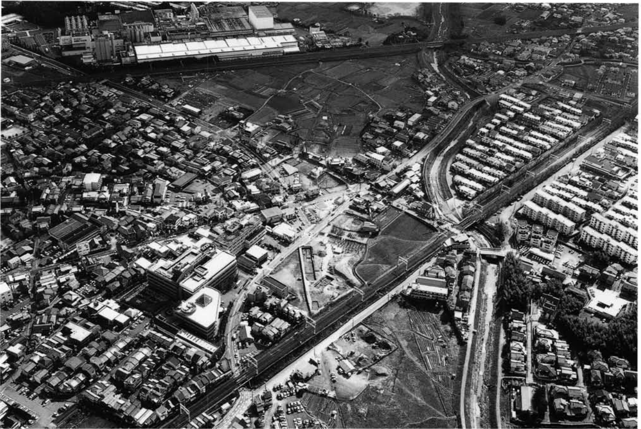
(1)友岡・調子地区調査地全景(北東から)
