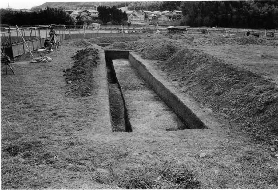
(1)上内田地区：6トレンチ全景 (北北東から)
