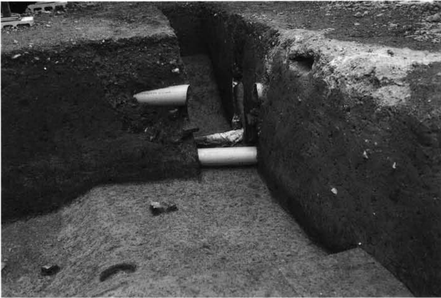
(1)溝 S D86303西拡張区(北から)
