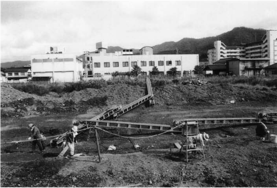
(1)第1トレンチ掘削風景(西から)
