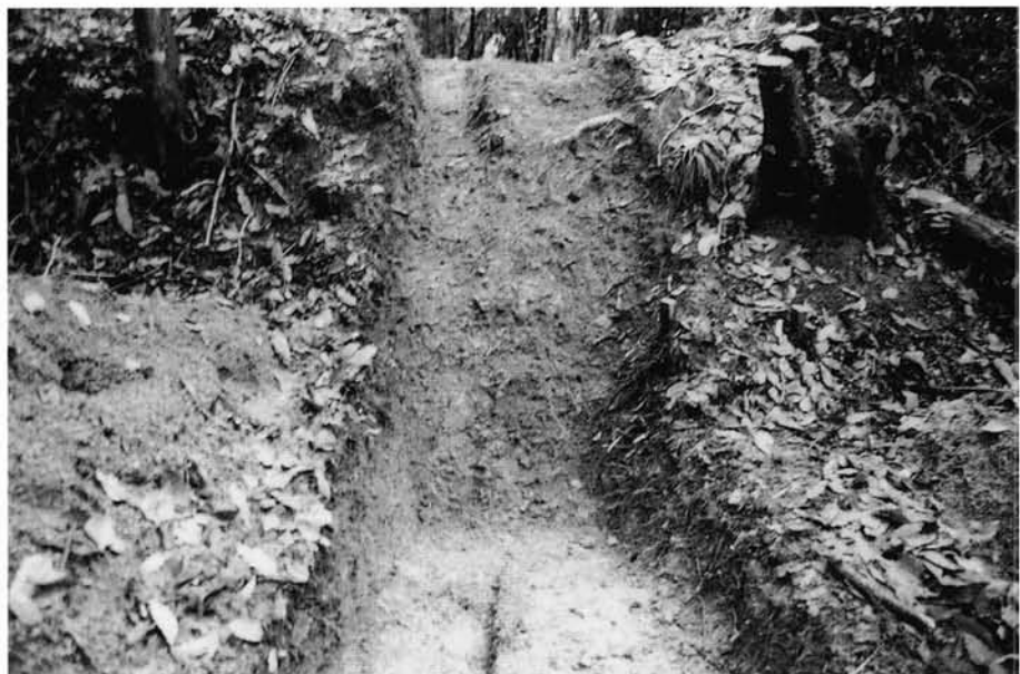
(3) 4トレンチ斜面・犬走り全景 (南から)
