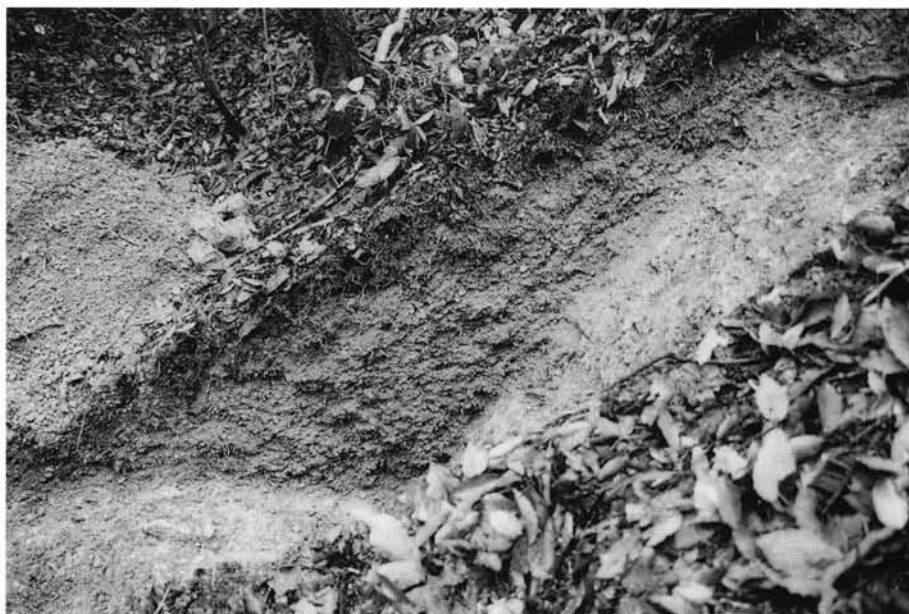
(1) 4 トレンチ斜面・犬走り断面 (東から)
