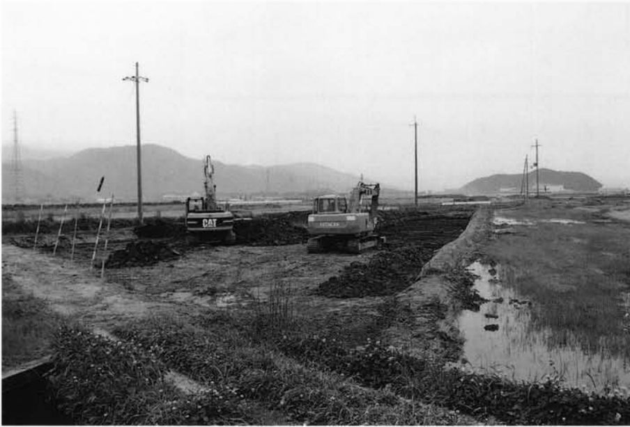
(1) 野条遺跡第11次重機掘削風景 (北西から)
