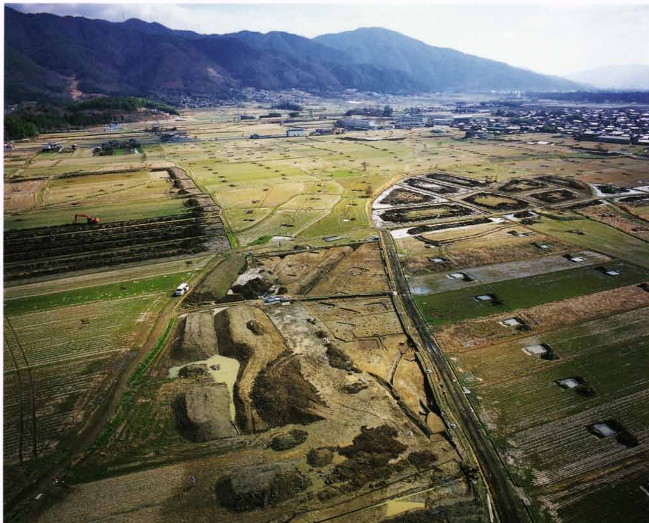
(1)池尻遺跡第12次調査地全景(北西から)
