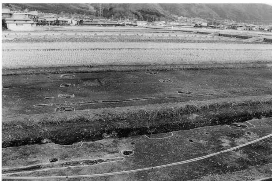
(3) D 地区掘立柱建物跡 S B 02 掘削 状況(北西から)
