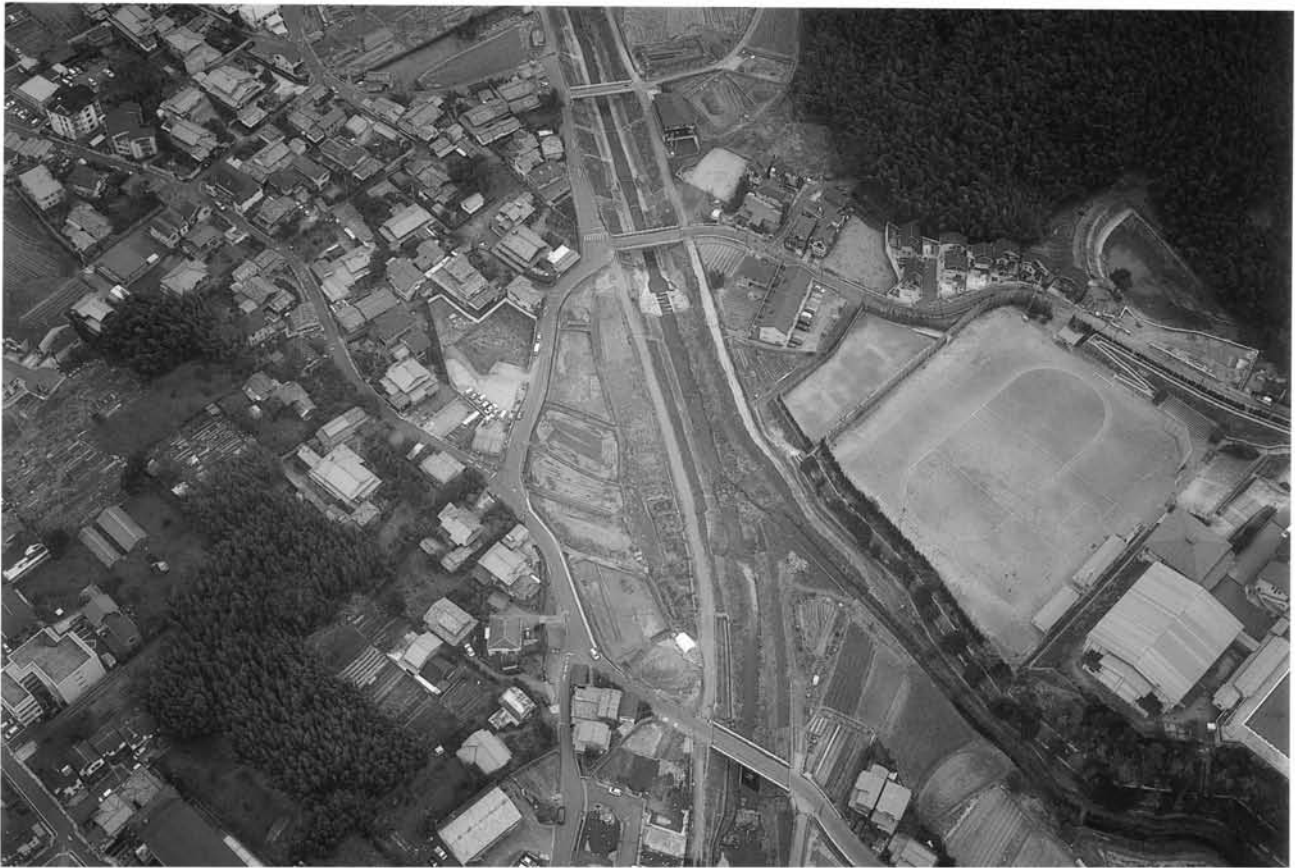
(1)西条・尾流地区全景(北西から)
