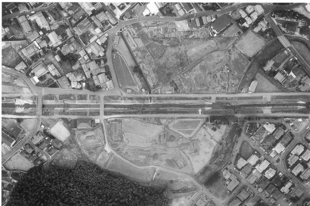
(2)上内田地区全景(上が南西)
