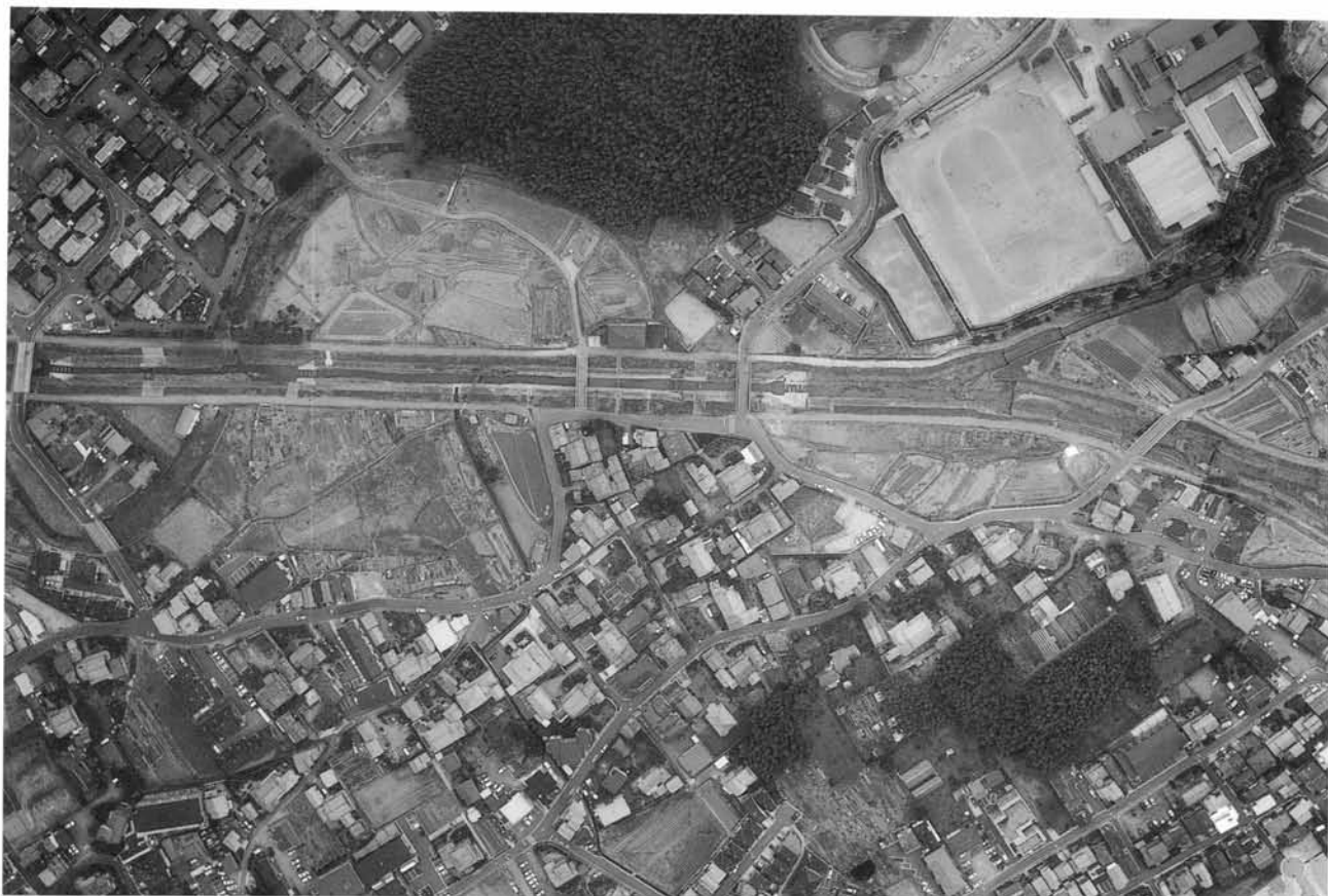
(1)西条・尾流・上内田地区全景(上が北)
