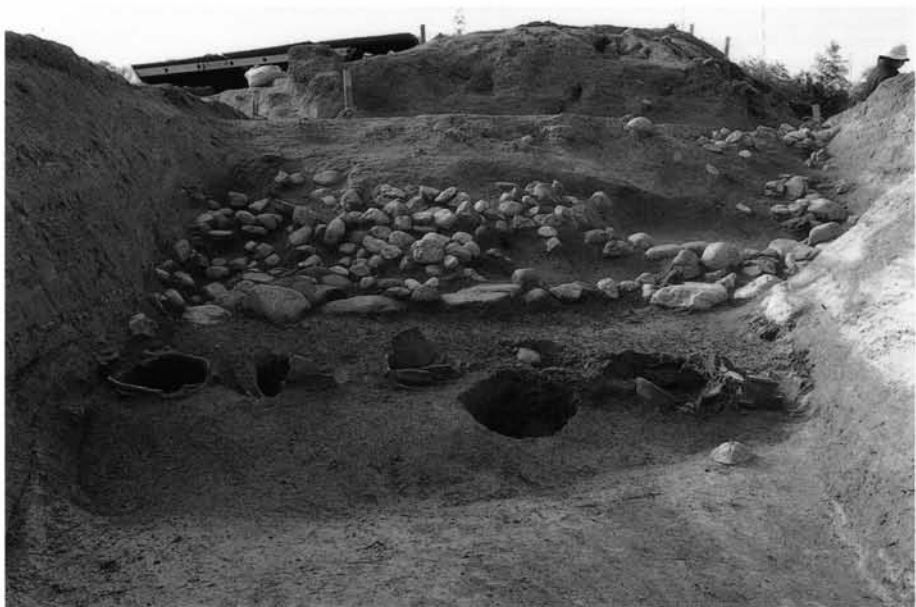
(3)同・転落葺石除去後葺石 基底部・埴輪列2(東から)
