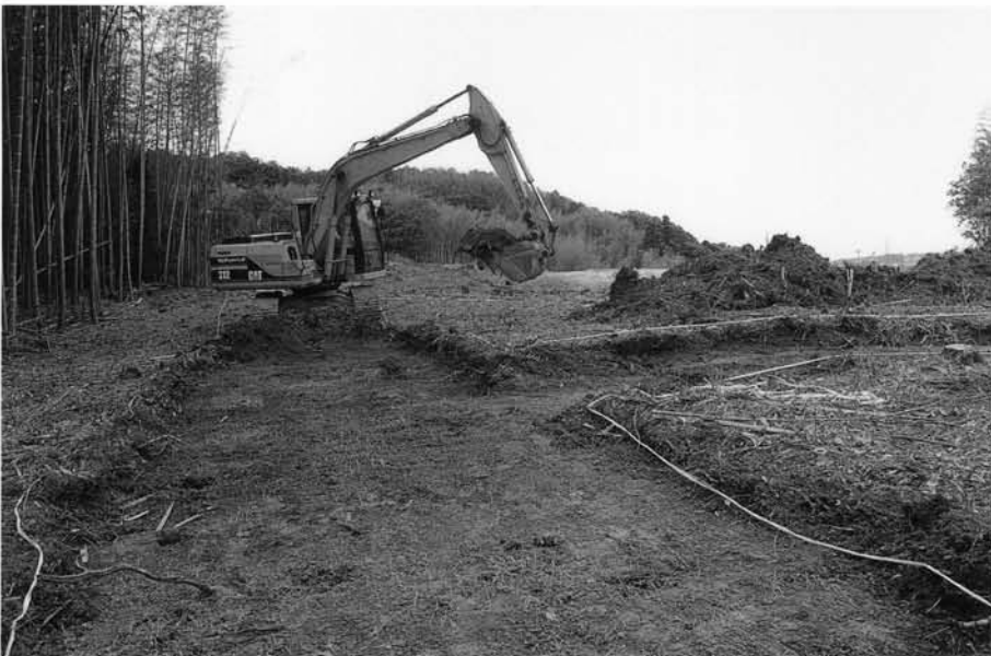
(3)表土および竹根除去作業 (北から)
