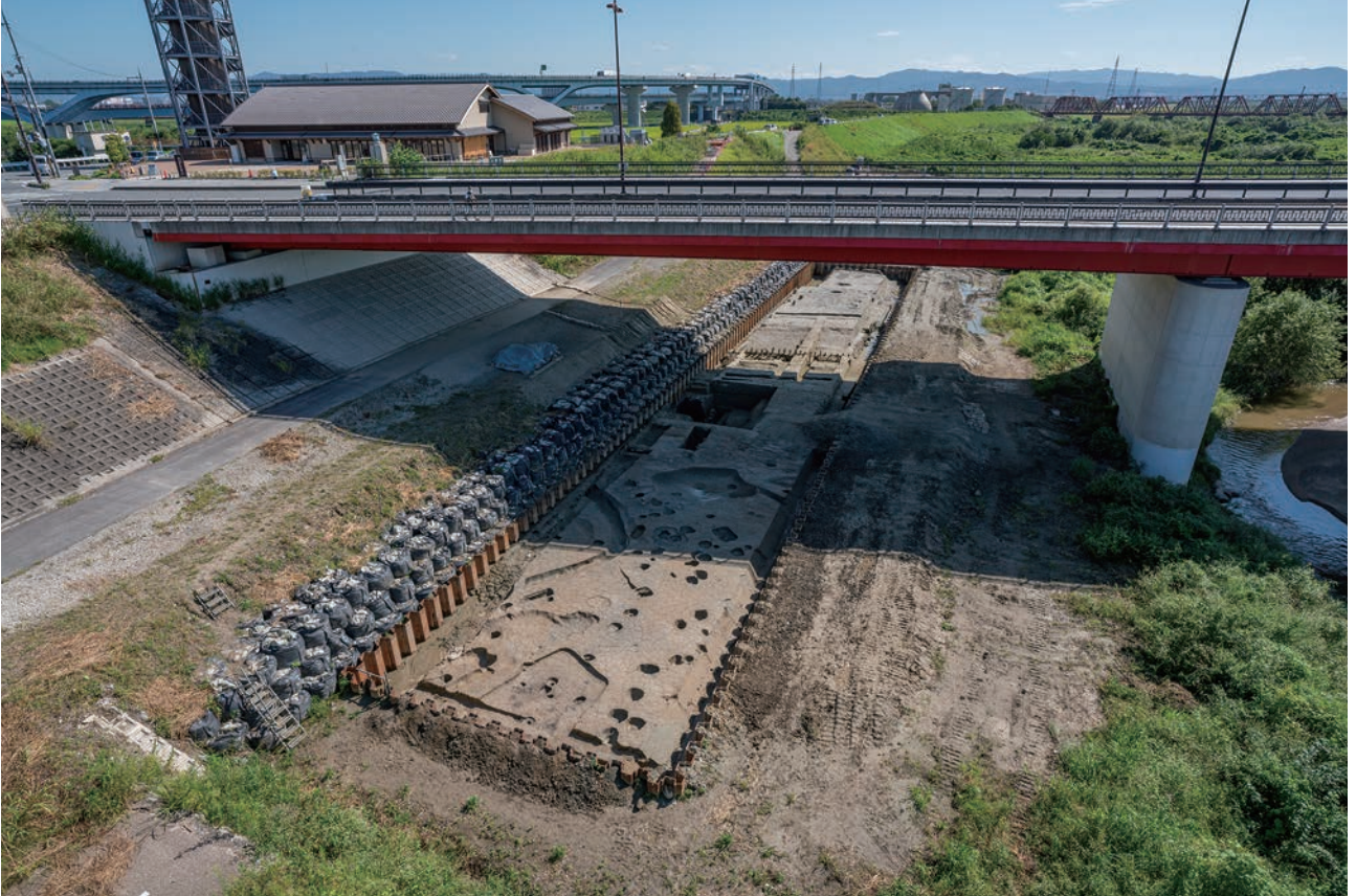
(1) 遺構面掘削状況(西から)
