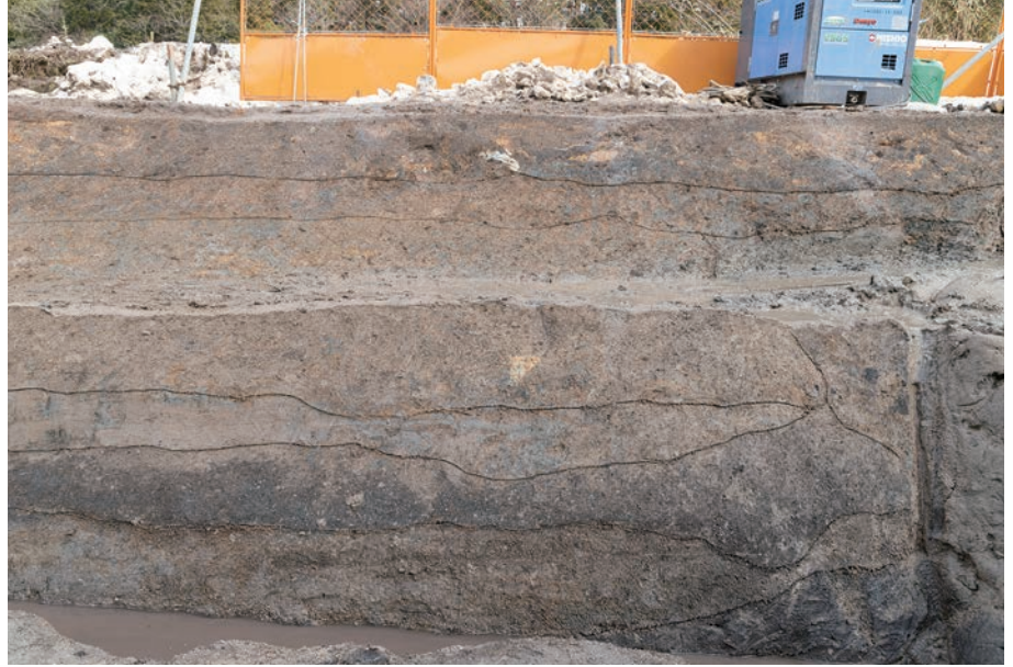
(1)南東隅東壁断面(西から)
