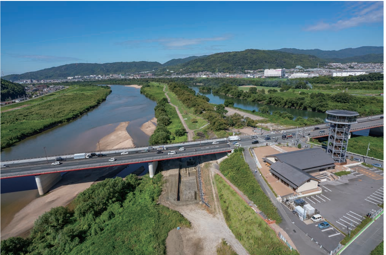
(2) 調査区遠景(東から)
