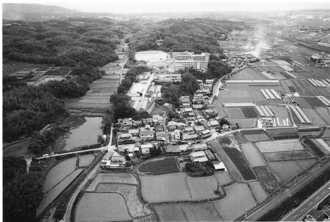
(2) 調査地遠景（北から）
