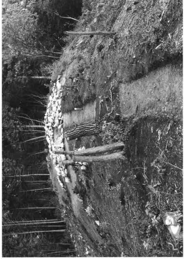
(4) トレンチ掘削状況 (南から)
