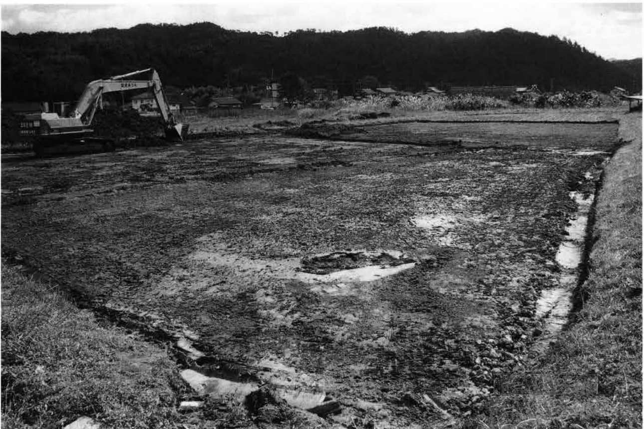
(2) 第1トレンチ重機掘削状況（北西から）
