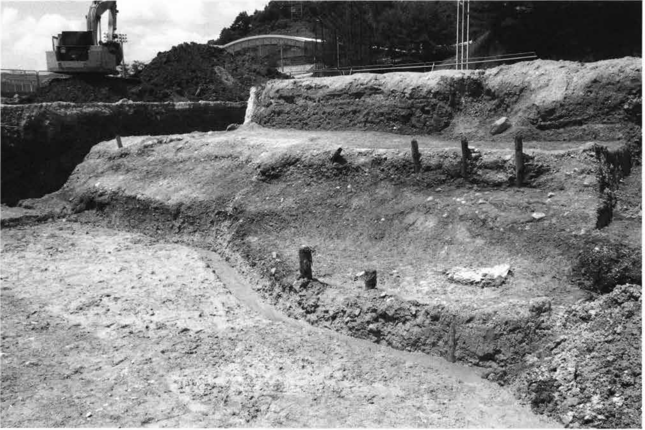
(1) 中堀検出状況（南から）
