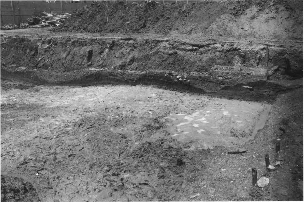
(1) 中堀掘削状況 (東から)
