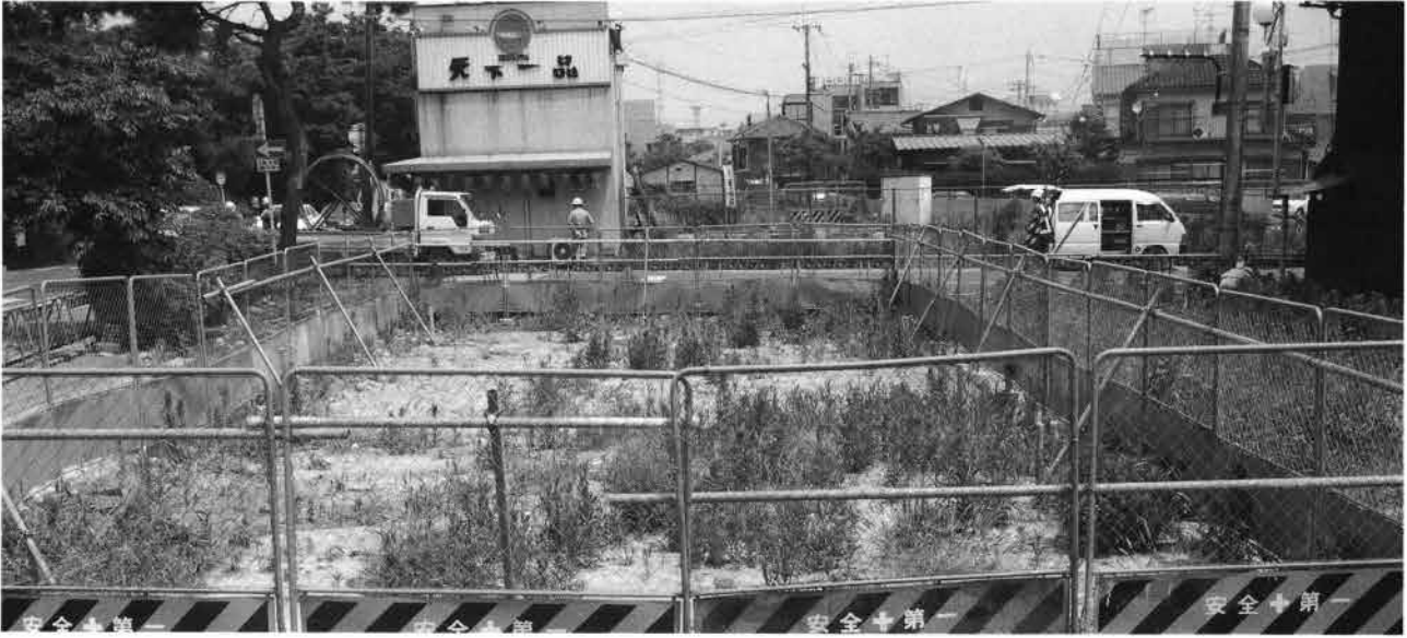
(1) 2トレンチ調査前全景（南から）
