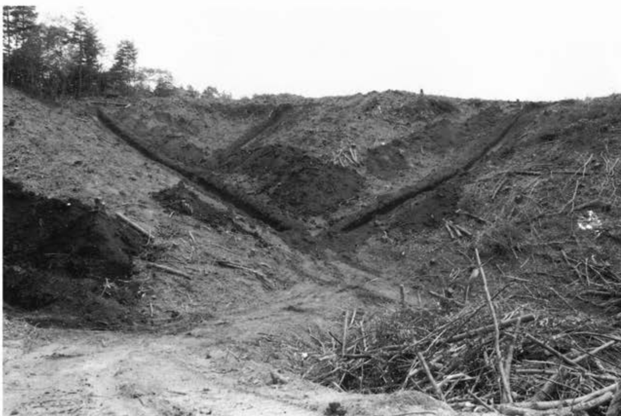
(2)中谷地区第8・10・11トレンチ全景（北から）
