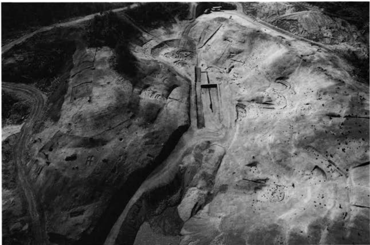
(2) 奈具岡遺跡全景 (北から)
