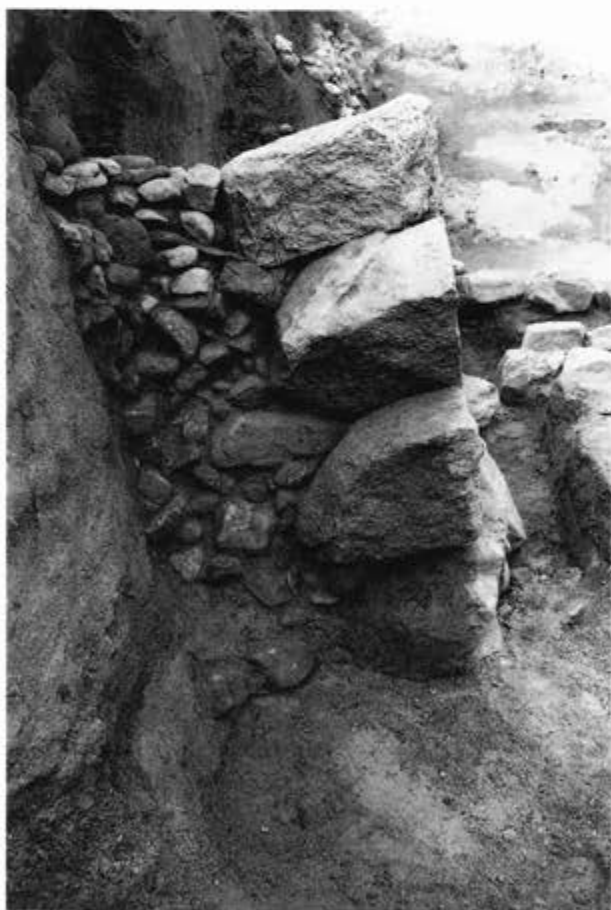
(2)石垣断面（南から）
