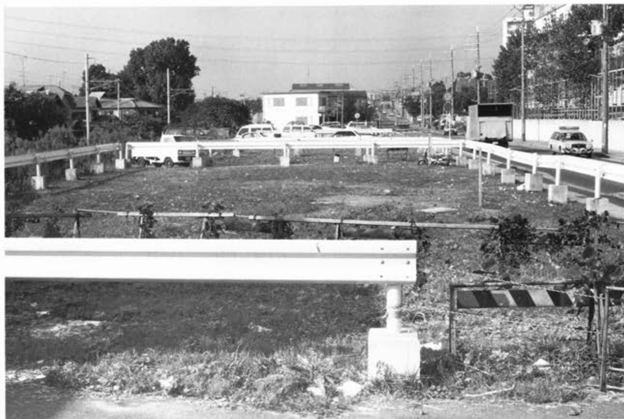
(1)菟道遺跡調査前風景（南から）
