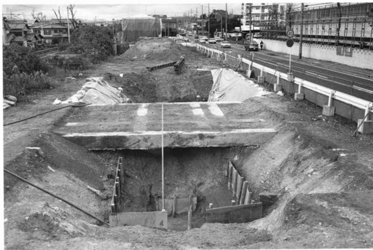
(2)菟道遺跡調査トレンチ全景（南から）
