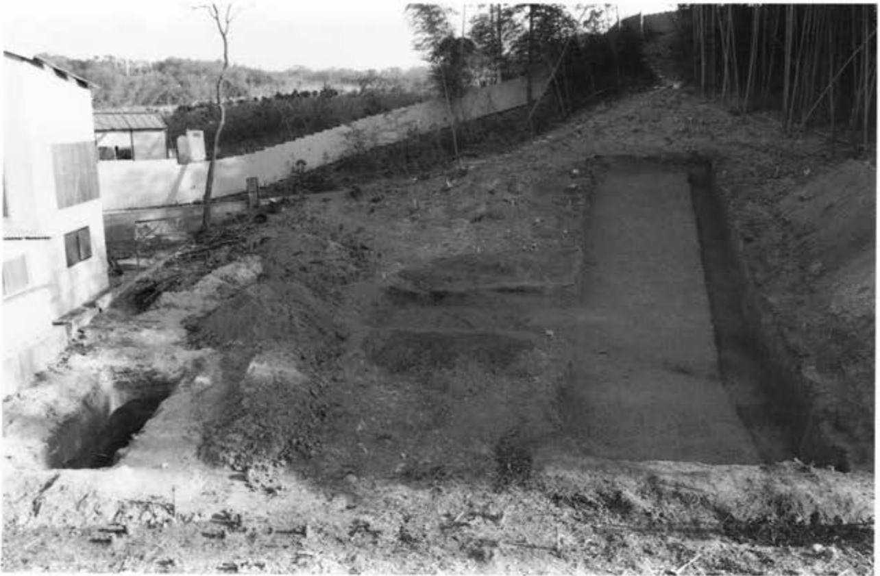
(1)第1・第2トレンチ完掘状況（北西から）
