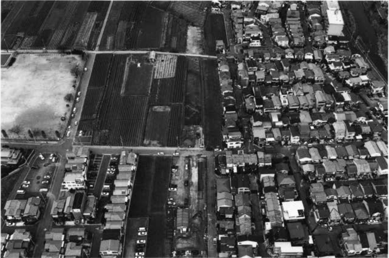
(1)調査地全景 (南から)
