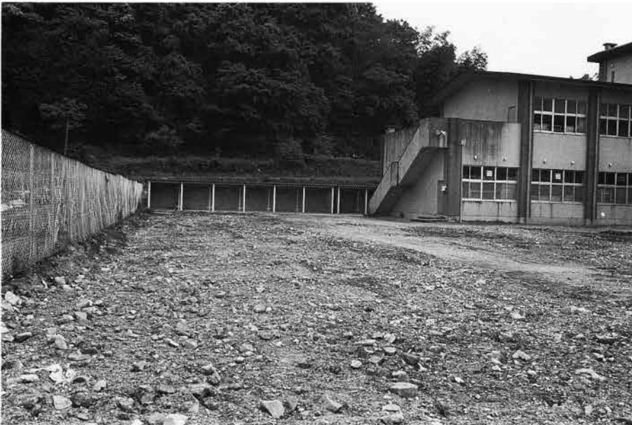
(2)調査前風景（西から）
