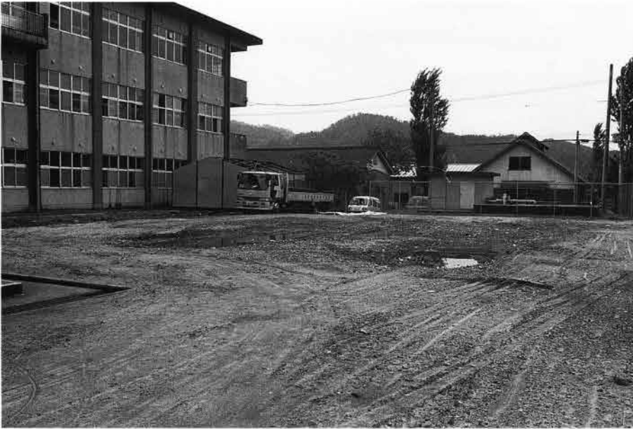
(1)調査前風景（北東から）
