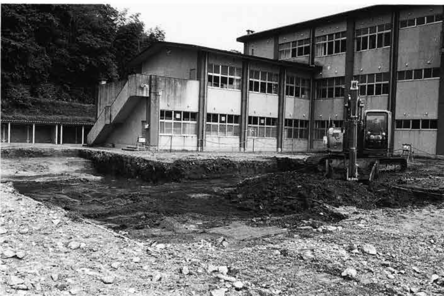
(3)重機掘削風景（北西から）
