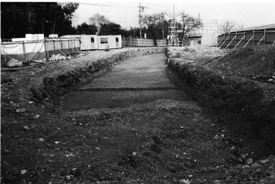
(3)トレンチ完掘状況 (西から)
