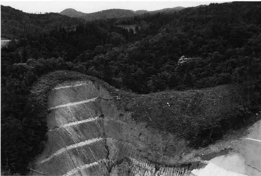
(2)調査前風景 (南から)
