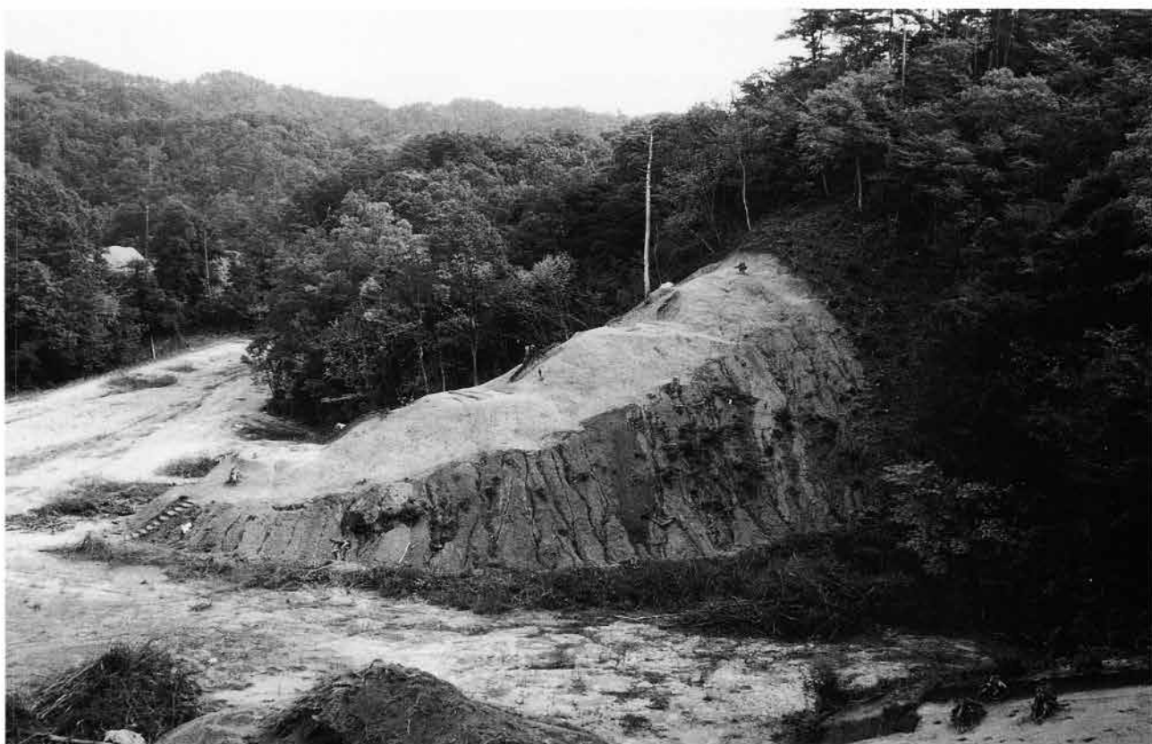
(2)E支群全景（西から）
