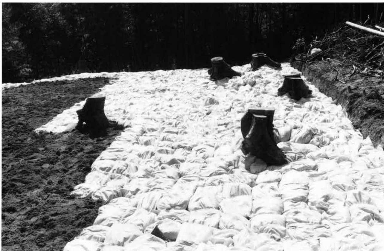
(1)墳頂部埋め戻し状況（北から）
