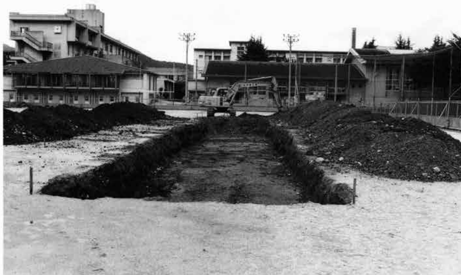
(2)重機掘削作業 (南から)
