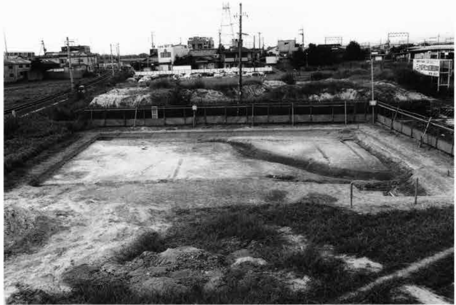
(1)第4トレンチ近景(南から)
