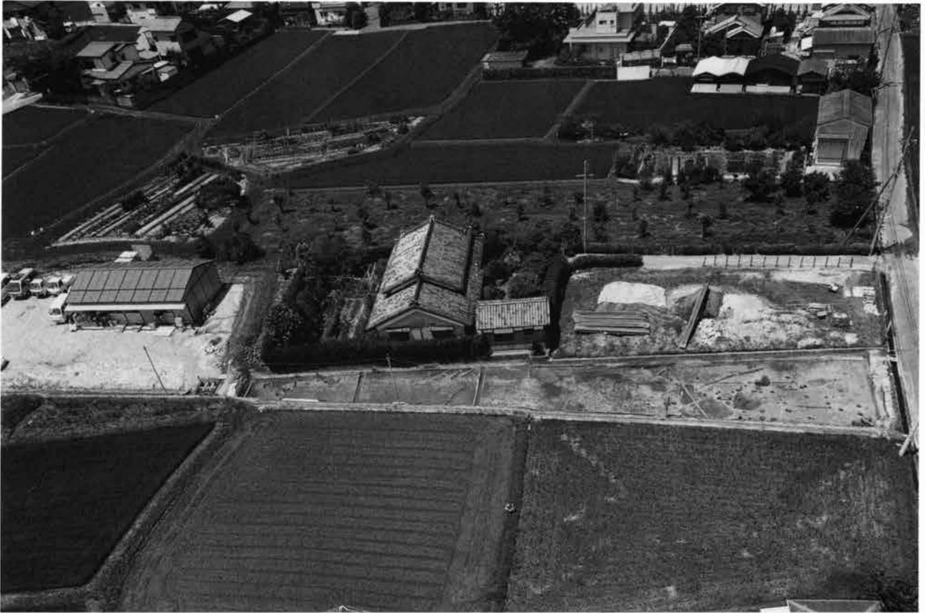
(1) B 1 地区全景 (東から)
