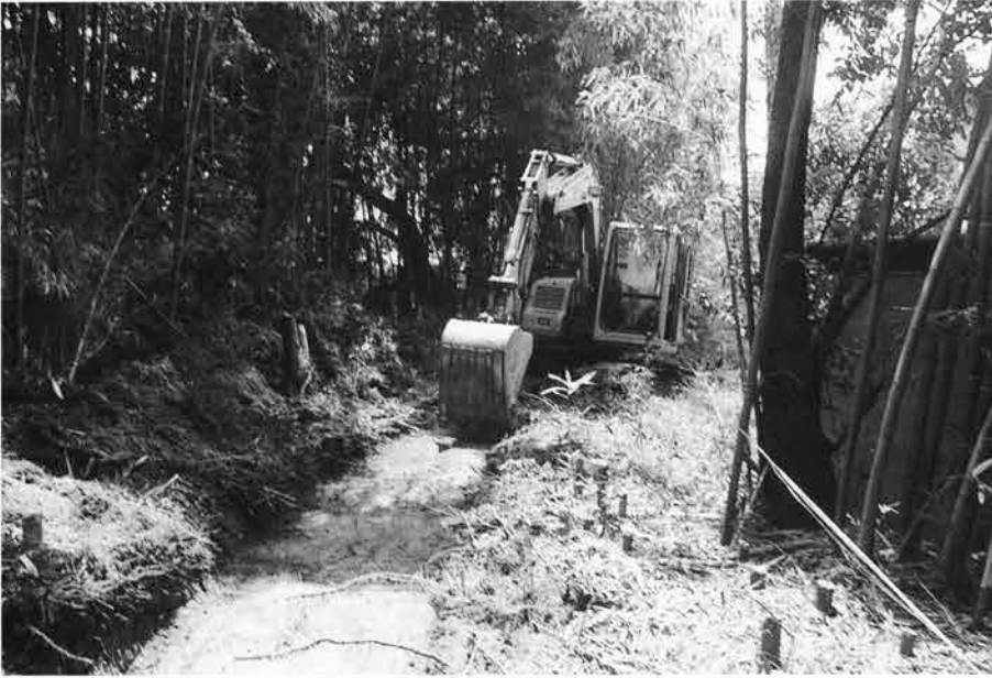
(1) 第2トレンチ重機掘削風景 (北西から)
