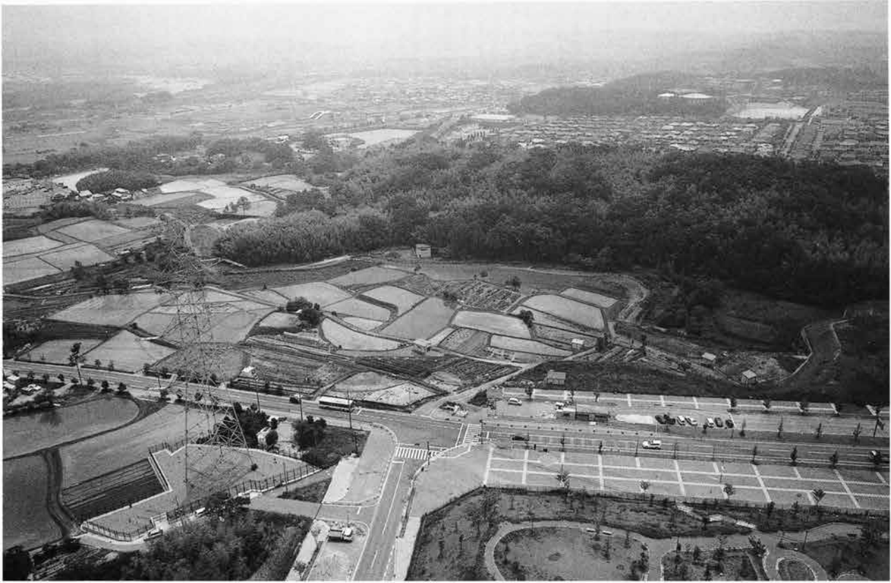
(1) 調査地遠景(北から)
