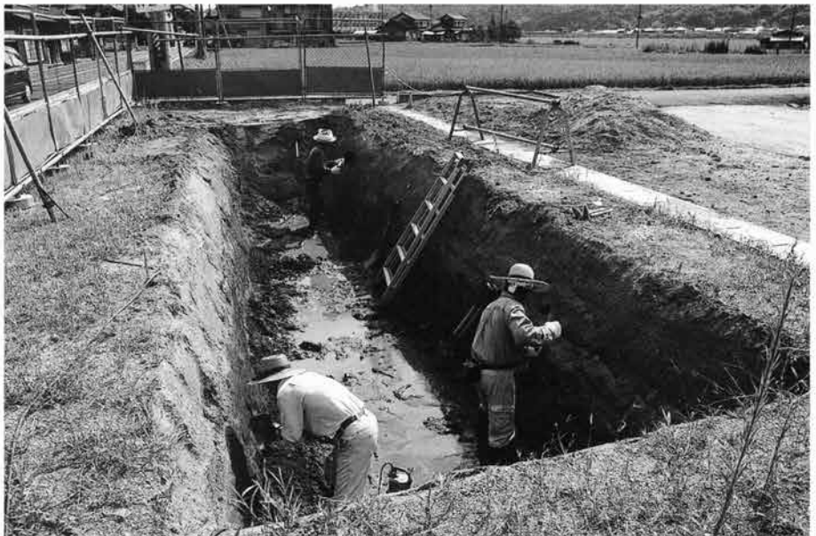
(3) 第1トレンチ作業風景 (南西から)
