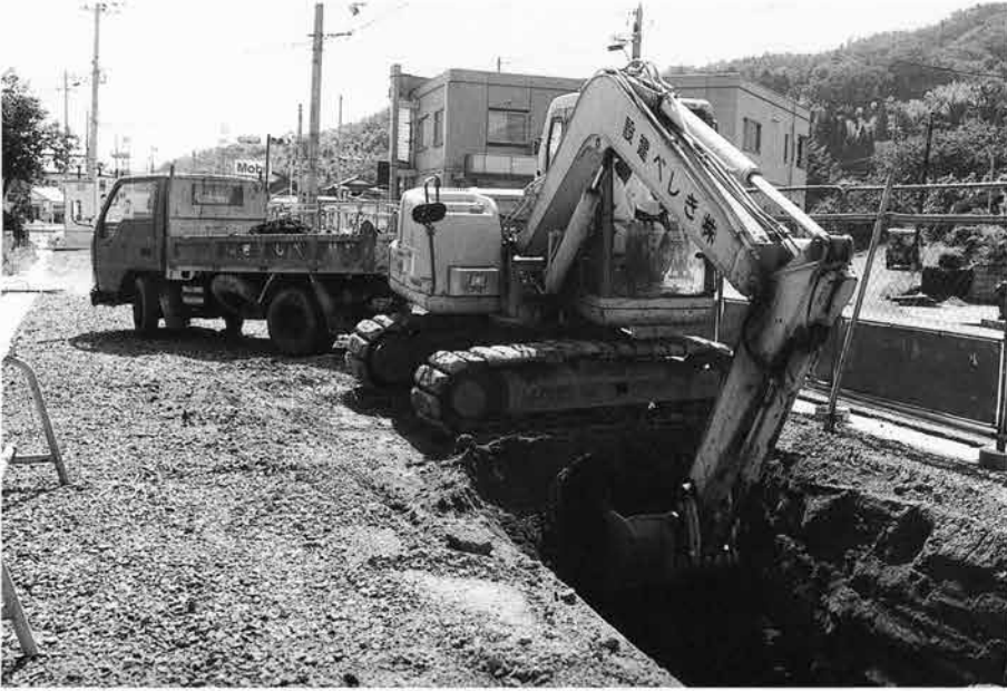
(1) 第2トレンチ重機掘削風景 (東から)
