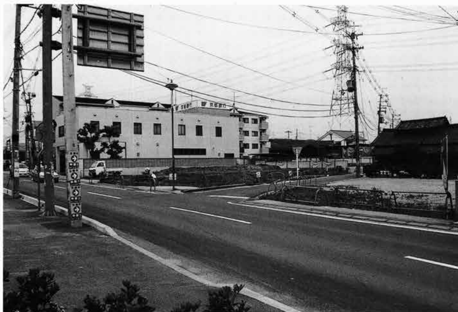
(1) 第1トレンチ調査前全景 (南東から)
