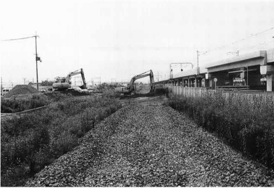
(1) 第1・2トレンチ重機掘削 状況(北から)
