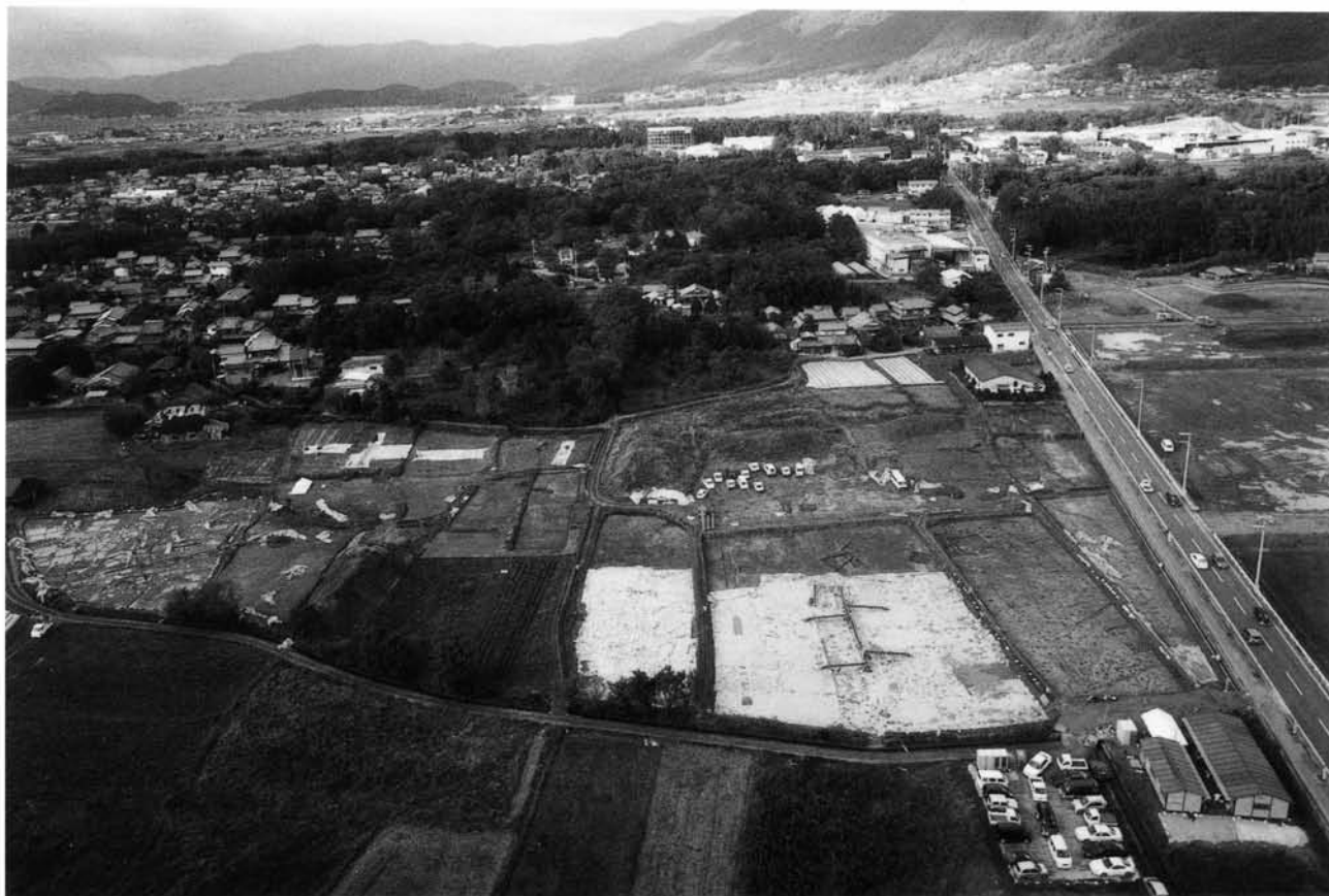
(1)調査地全景(南から)
