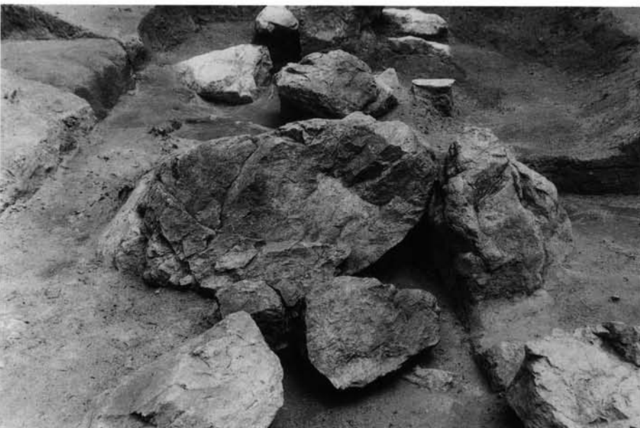
(3)三角4号墳玄門部の崩落した 天井石(北から)
