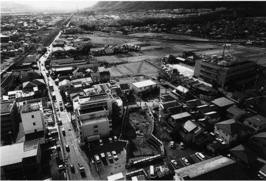
(1)C-2・3地区全景(北東から)
