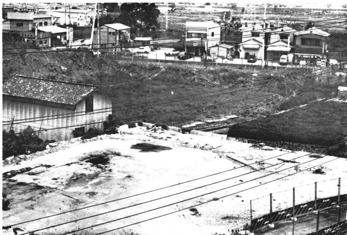
(1) 第2調査区調査前全景(北東から)
