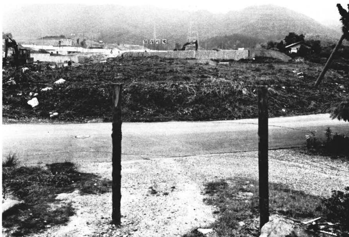
(1) 第1調査区調査前全景(西から)
