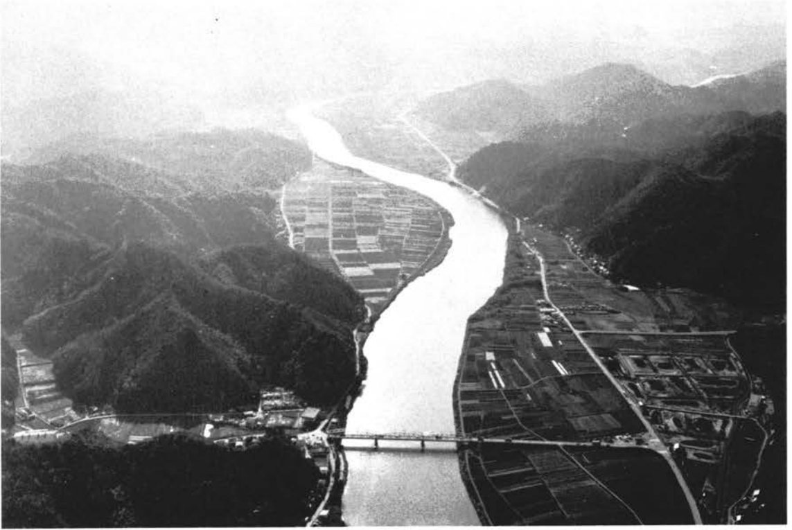
(1) 由良川下流域全景
