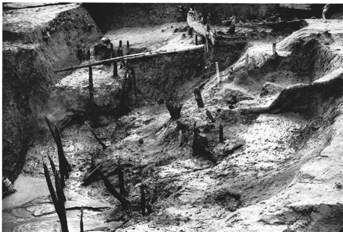
(1) 近世排水施設（西から）
