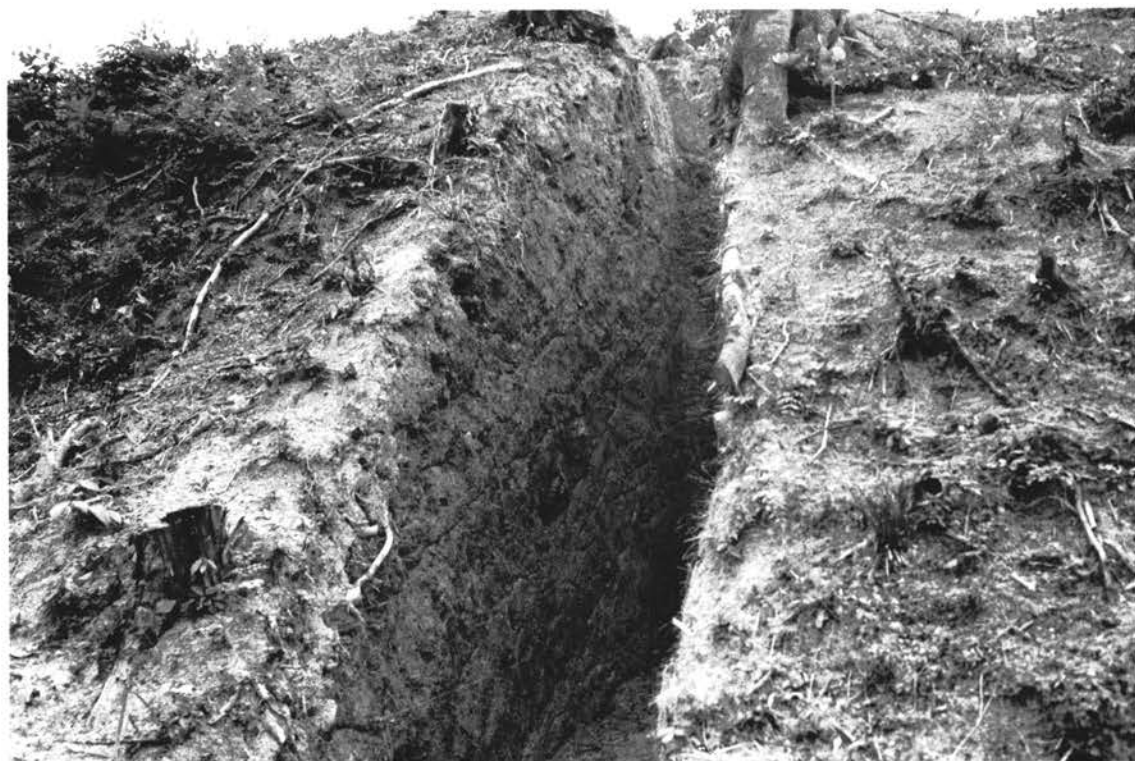
(2) 平山城跡 土塁構築状況(北西から)
