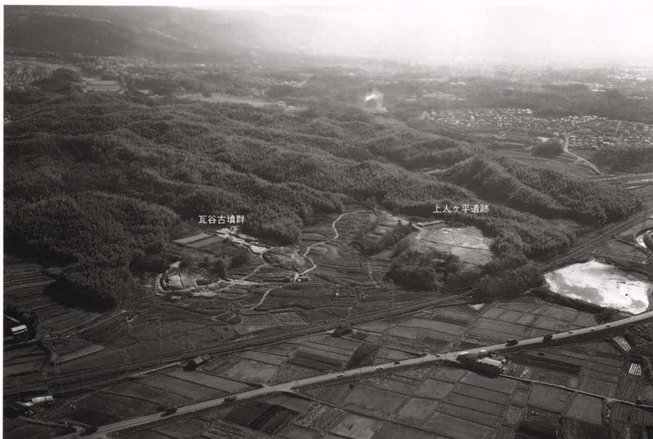
(1)調査地遠景（北西から）
