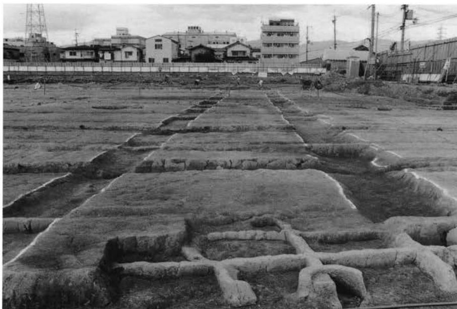
(1)A地区 二条条間北小路 南側溝(右)・S D362103 (左) (東から)
