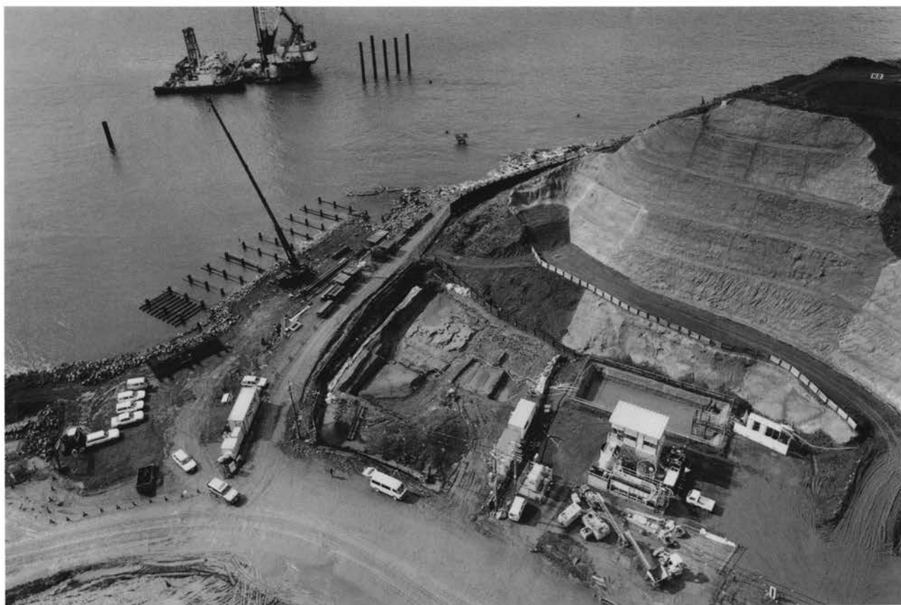
(1)R地点遠景（北東から）
