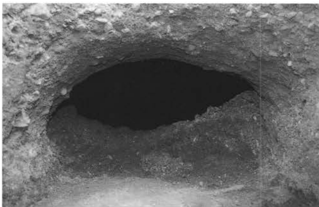
(1) 荒坂B支群5号横穴横穴開口状況(北北西から)
