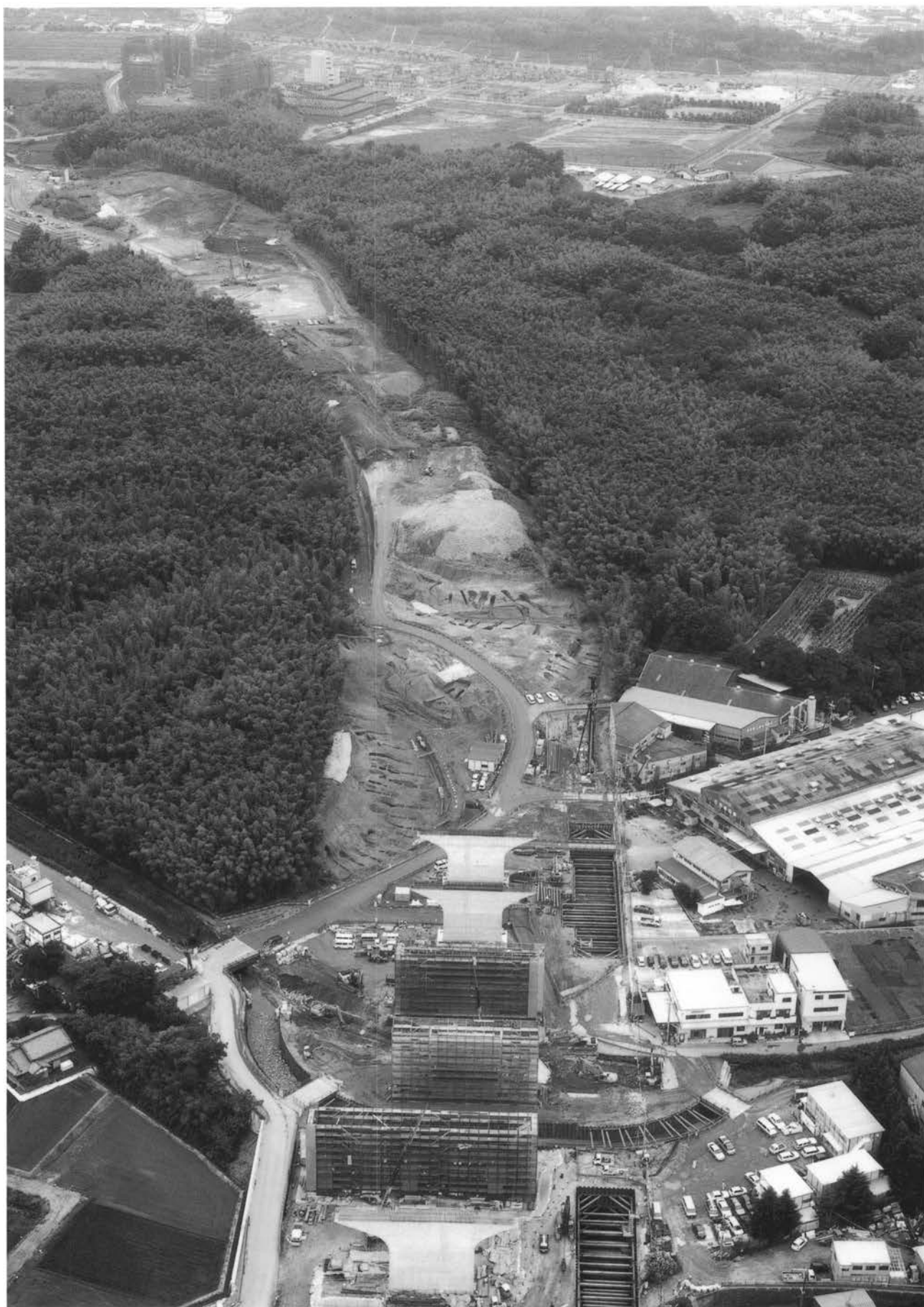
女谷・荒坂横穴群全景(北東から)
