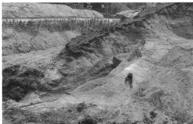
(3) 荒坂A支群導水施設4・5全景(北から)
