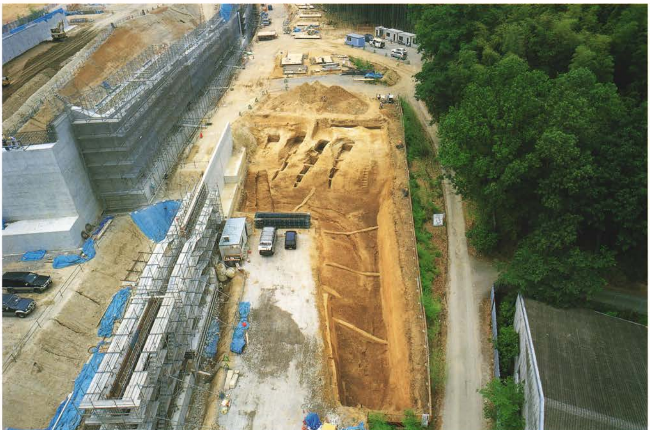
(2)女谷B支群15～18号横穴全景(北東から)
