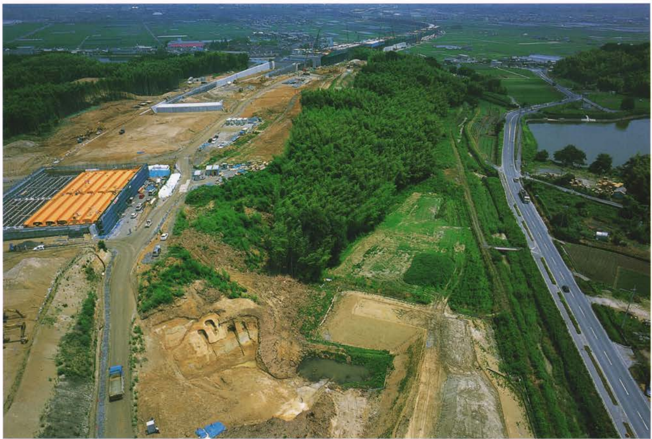
(1)荒坂A支群全景(南西から)
