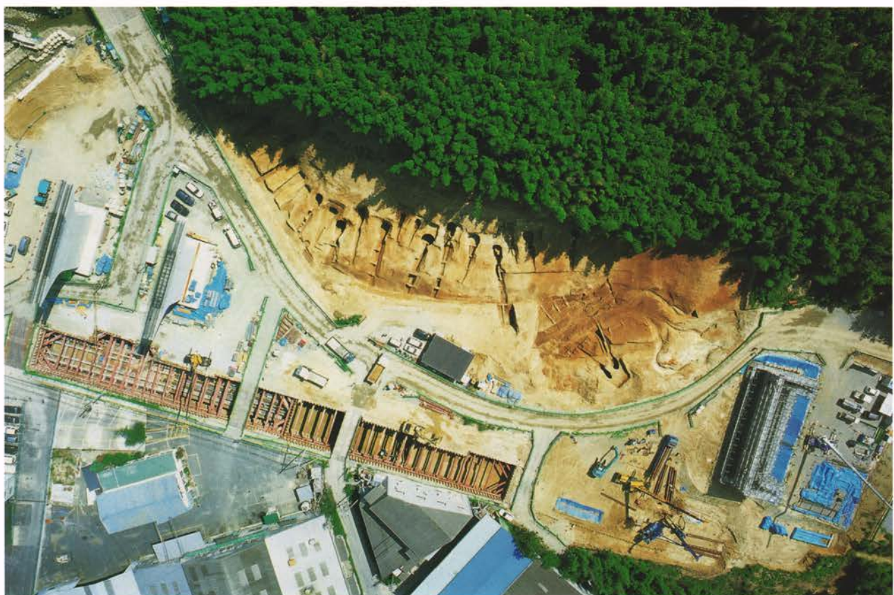
(2)荒坂B・C支群全景(上が東)
