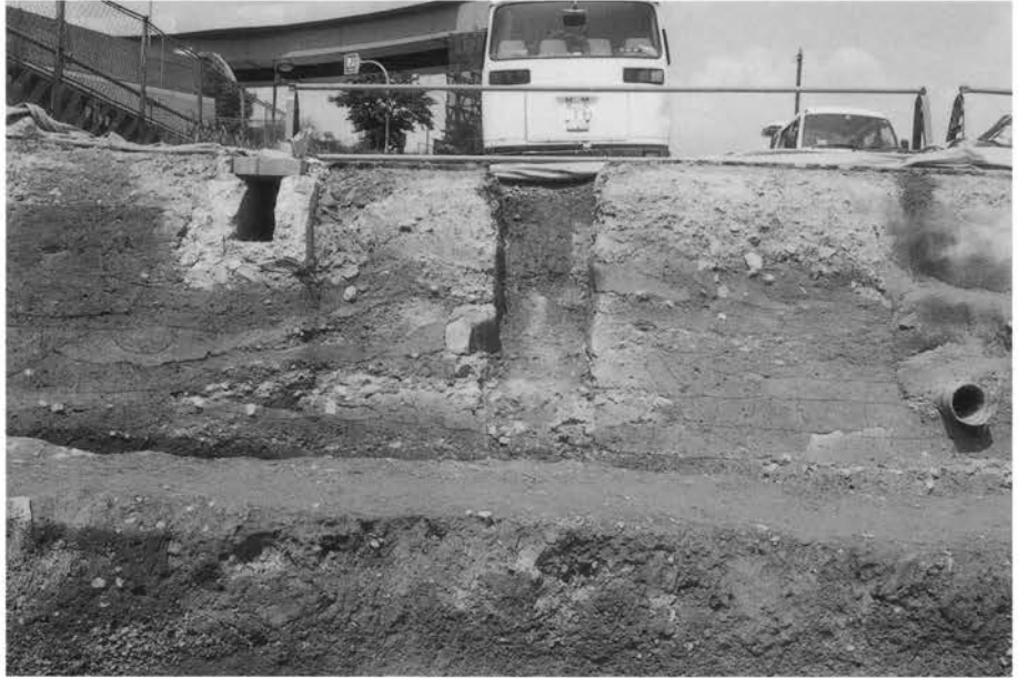
(1) I-1 トレンチ西壁土層断面 (南西から)
