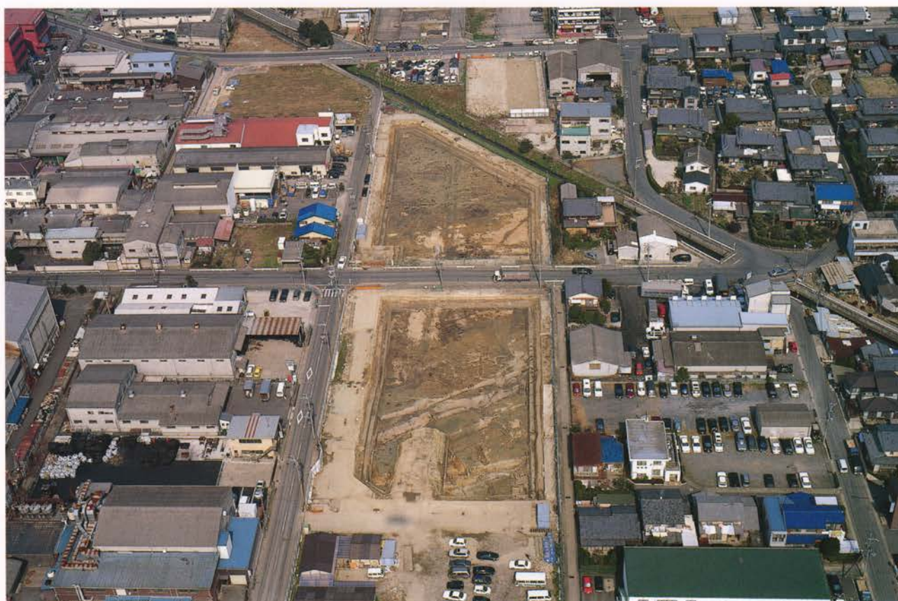
(2)B・C 調査区(1次調査)弥生時代遺構面全景
