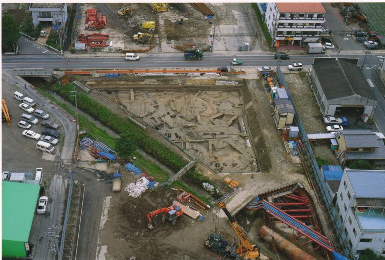
(1)A 調査区(3次調査)弥生時代遺構面全景
