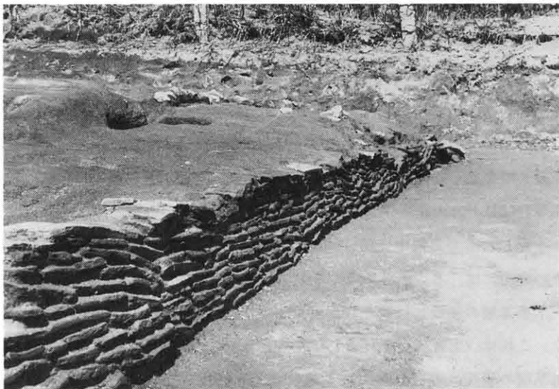
写真1 下層基壇瓦積細部状況(東側)
