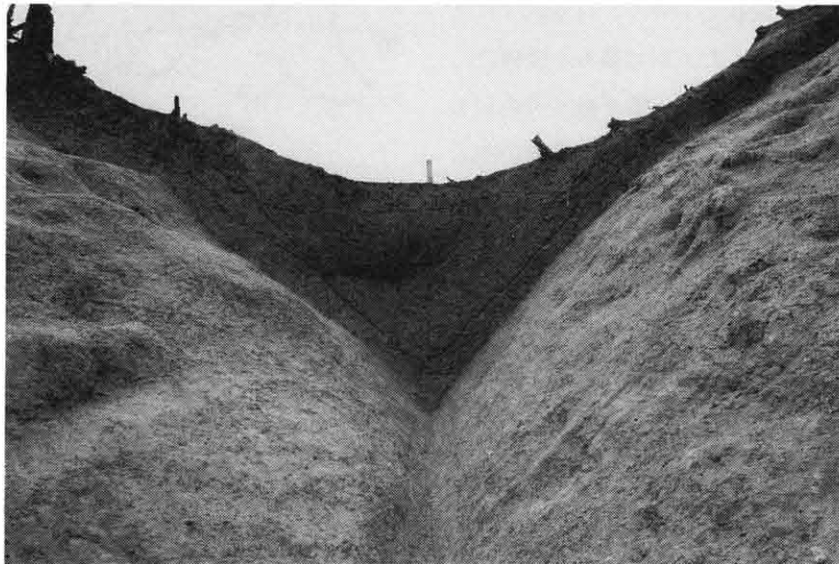
堀切の状況(東から)
